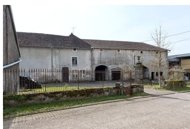
Vue d'ensemble, façade principale. Phot. Sonia Dourlot IVR43_20167000596NUC4A
