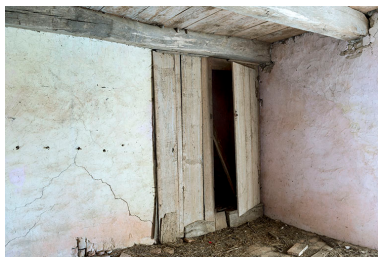
Porte pour accéder à l'étage du pigeonnier. Phot. Sonia Dourlot IVR43_20167000605NUC4A
