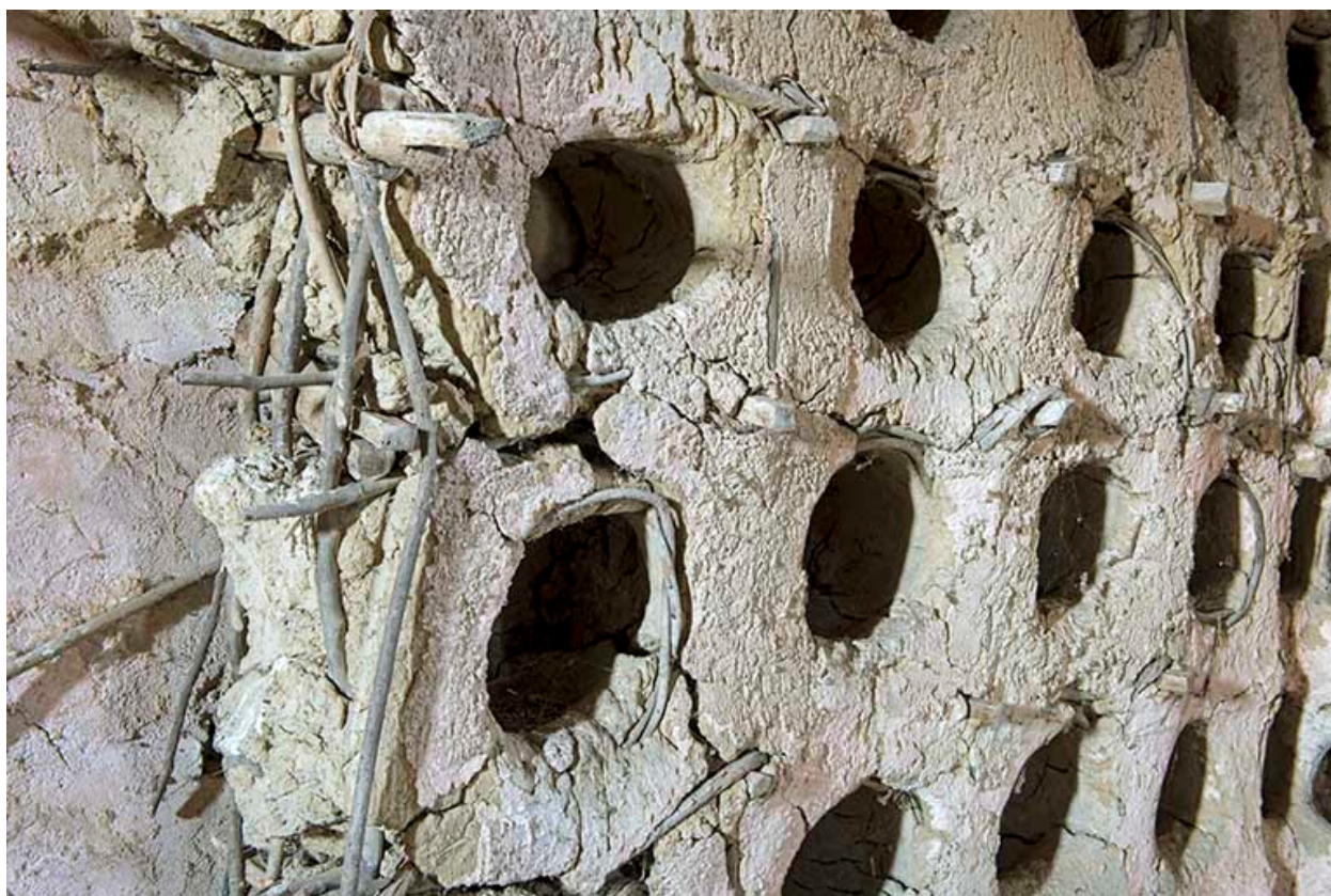
Détail sur la construction des boulins.
