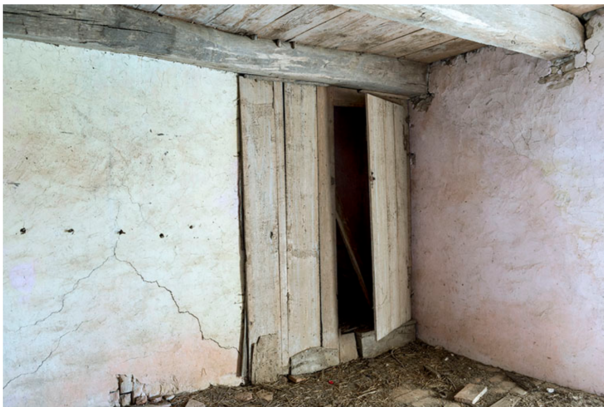
Porte pour accéder à l'étage du pigeonier.
