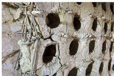
Détail sur la construction des boulins. Phot. Sonia Dourlot IVR43_20167000609NUC4A
