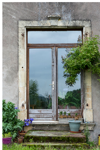
Détail d'une porte, façade postérieure.
