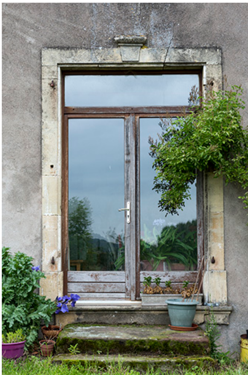
Détail d'une porte, façade postérieure.
