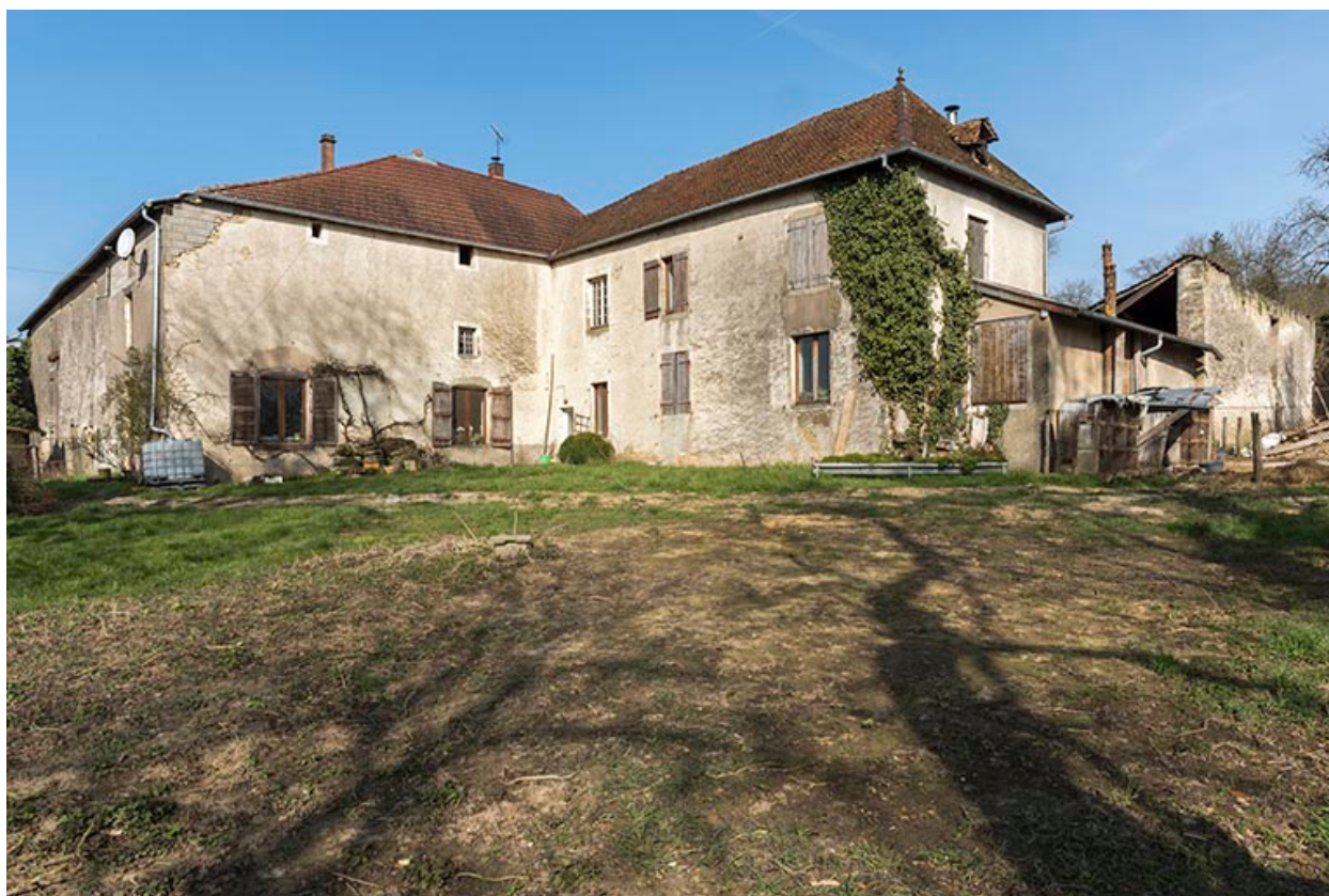
Vue générale, façade postérieure.
