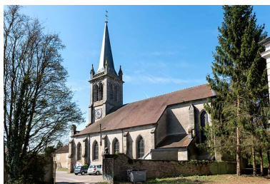
Vue d'ensemble depuis le parc du château. Phot. Sonia Dourlot IVR43_20167000529NUC4A
