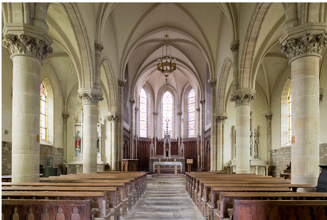
La nef depuis l'entrée.
