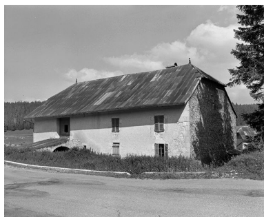
Façade postérieure. Phot. Yves Sancey IVR43_19782500418X
