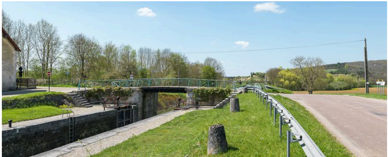
Le pont depuis le sas.
