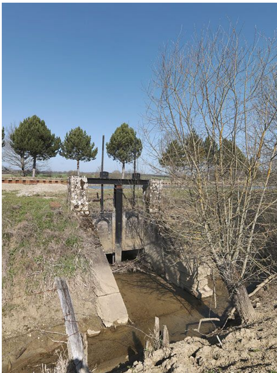
L'aqueduc-déversoir avec ses vannes passant sous le canal en amont du site d'écluse 16.
