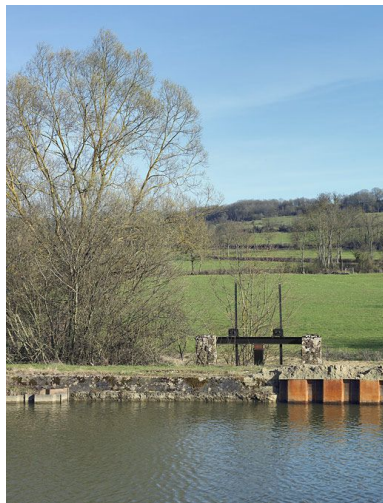
L'aqueduc-déversoir avec ses vannes passant sous le canal en amont du site d'écluse 16.
