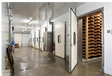
Cave d'affinage : couloir desservant les pièces. Phot. Sonia Dourlot IVR43_20182501706NUC4A
