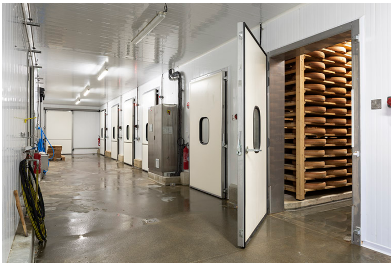
Cave d'affinage : couloir desservant les pièces.
