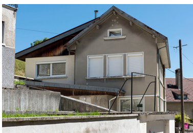
Atelier occidental : façade latérale gauche.
