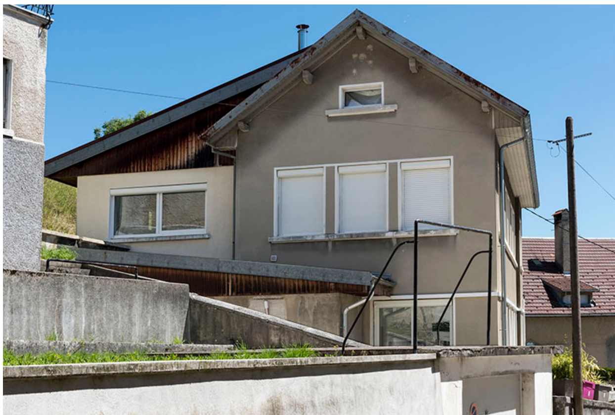
Atelier occidental : façade latérale gauche.
