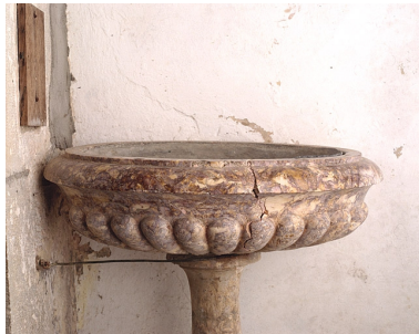
Détail de la cuve. Phot. Jérôme Mongreville IVR43_19973901873XA
