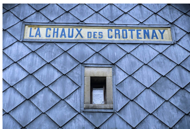
Bâtiment des voyageurs : nom de la gare porté sur l'élévation latérale sud (côté La Cluse). Phot. Yves Sancey IVR43_20043900220ZA
