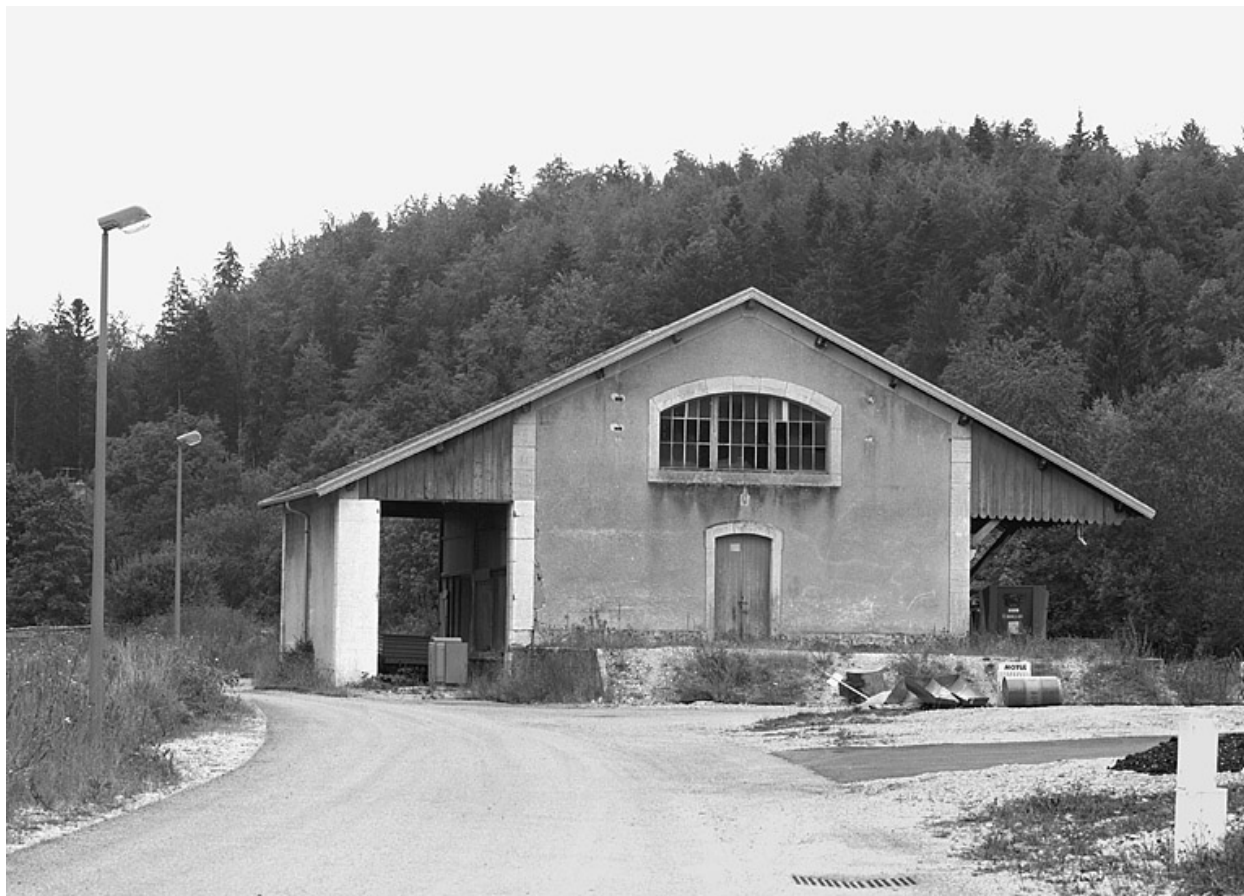
Entrepôt : façade antérieure (nord).
