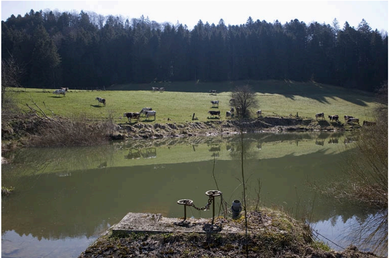
Réservoir : vue d'ensemble, depuis l'ouest.
