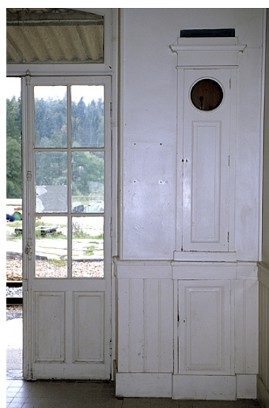
Bâtiment des voyageurs : caisse d'horloge comtoise encadrée dans le mur de la salle d'attente.
