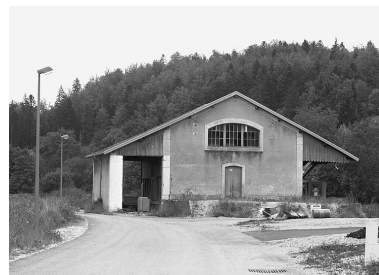
Entrepôt : façade antérieure (nord). Phot. Yves Sancey IVR43_20043900217X
