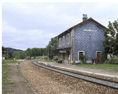
Bâtiment des voyageurs : façades postérieure (côté voie) et latérale droite. Phot. Yves Sancey IVR43_20043900211XA
