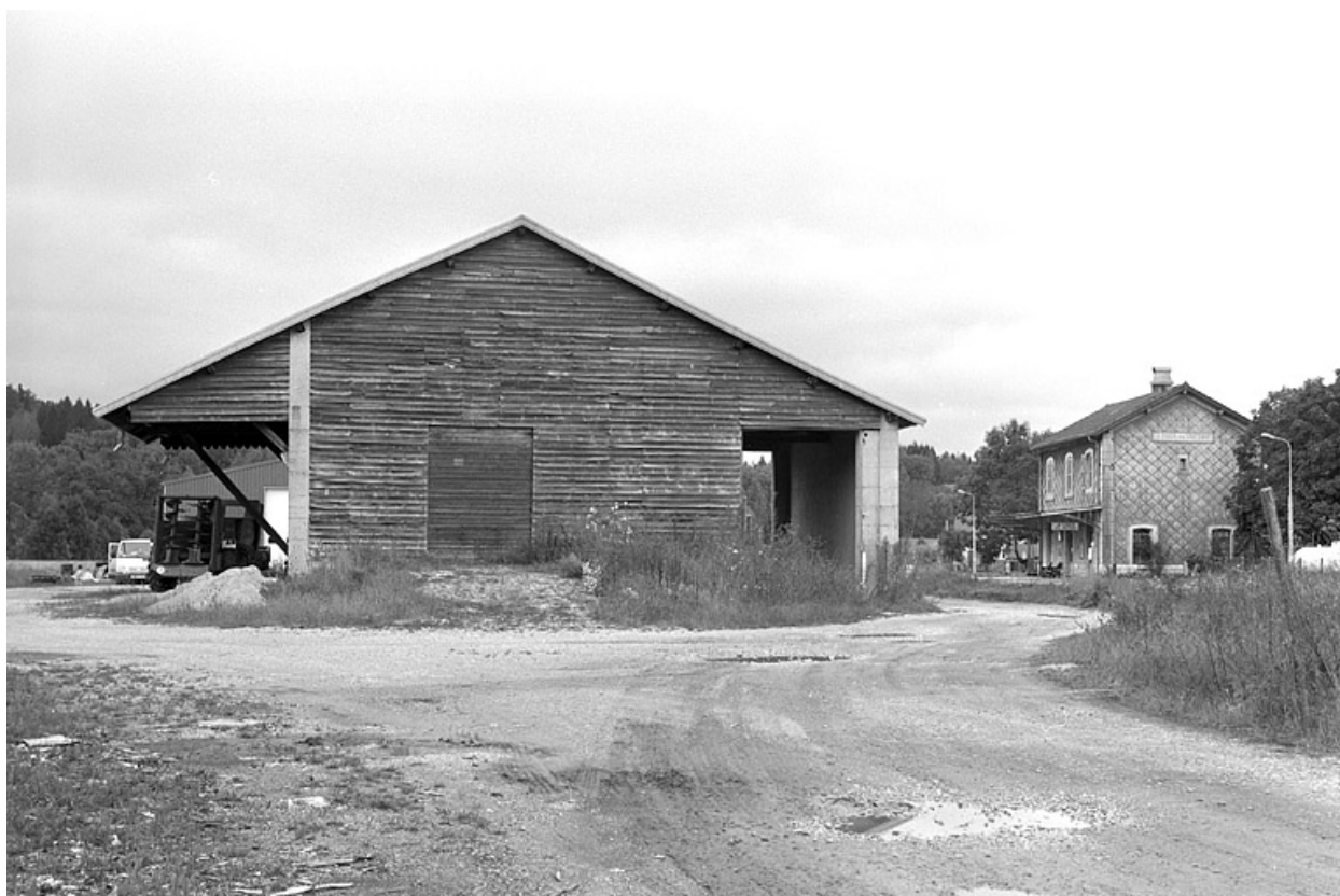
Entrepôt : façade postérieure (sud).
