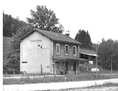
Bâtiment des voyageurs : façades postérieure (côté voie) et latérale gauche. Phot. Yves Sancey IVR43_20043900209X
