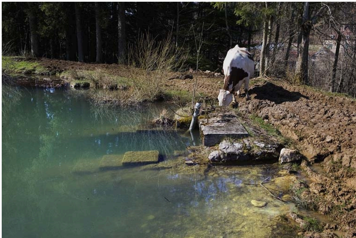
Réservoir : vannes de prise d'eau.
