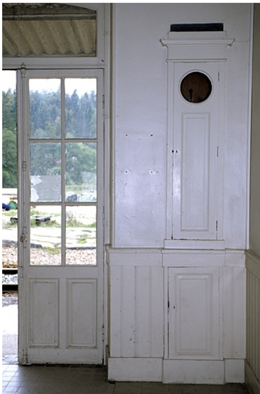
Bâtiment des voyageurs : caisse d'horloge comtoise encastrée dans le mur de la salle d'attente.
