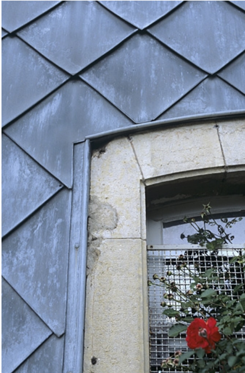
Bâtiment des voyageurs : détail de l'essentage de tôle de l'élévation latérale sud.
