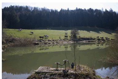
Réservoir : vue d'ensemble, depuis l'ouest. Phot. Yves Sancey IVR43_20073900157NUCA
