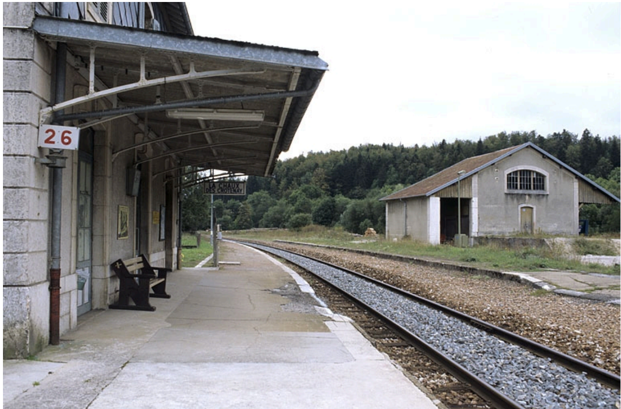
Quai des voyageurs, auvent et entrepôt commercial.
