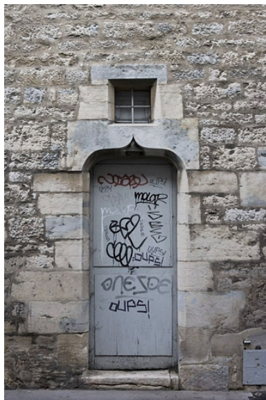
Façade latérale gauche : détail d'une porte en accolade. Phot. Yves Sancey IVR43_20092501295NUC2A
