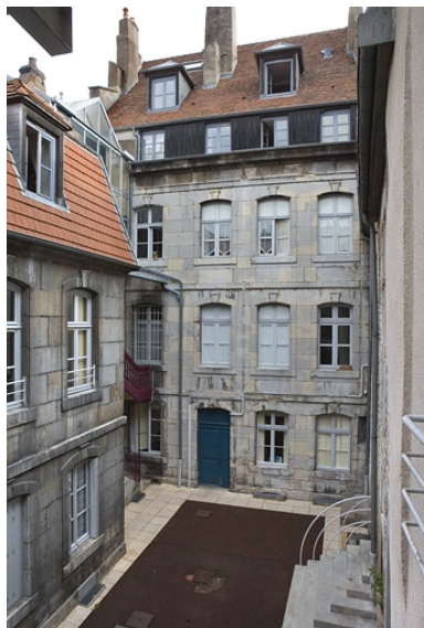
Vue d'ensemble de la cour depuis le fond. Phot. Yves Sancey IVR43_20092501305NUC2A
