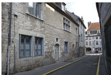
Vue d'ensemble de la façade latérale gauche, de trois quarts gauche. Phot. Yves Sancey IVR43_20092501296NUC2A
