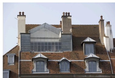
Toiture : détail de la verrière de l'atelier d'artiste. Phot. Yves Sancey IVR43_20092501292NUC2A
