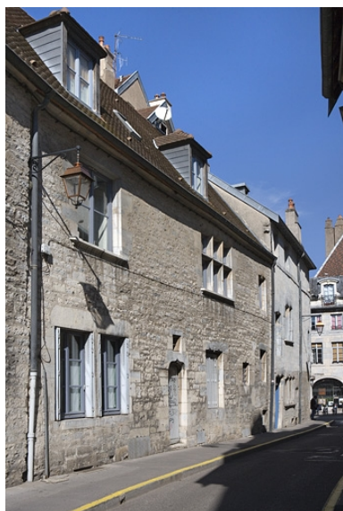
Façade latérale gauche, vue partielle. Phot. Yves Sancey IVR43_20092501300NUC2A
