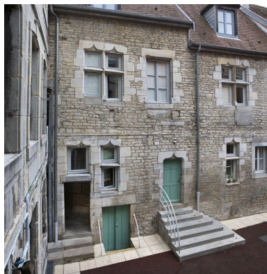
Vue d'une partie de l'aile gauche sur cour. Phot. Yves Sancey IVR43_20092501307NUC2A
