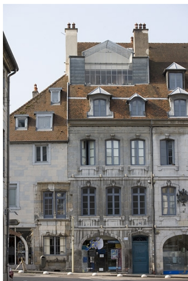
Partie gauche de la façade sur rue, de face. Phot. Yves Sancey IVR43_20092501291NUC2A
