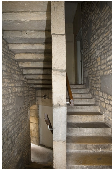
Détail de l'escalier rampe sur rampe dans oeuvre de l'aile gauche. Phot. Yves Sancey IVR43_20092501311NUC2A
