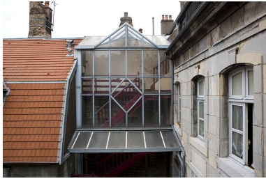
Détail de la verrière au-dessus de l'escalier à cage ouverte. Phot. Yves Sancey IVR43_20092501312NUC2A
