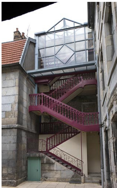
Vue d'ensemble de l'escalier à cage ouverte. Phot. Yves Sancey IVR43_20092501313NUC2A
