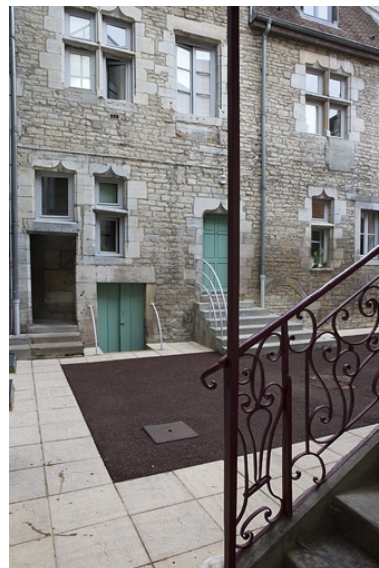
Vue de l'aile gauche depuis l'escalier à cage ouverte. Phot. Yves Sancey IVR43_20092501310NUC2A
