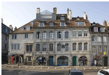
Vue d'ensemble de la façade sur rue, de face. Phot. Yves Sancey IVR43_20092501285NUC2A
