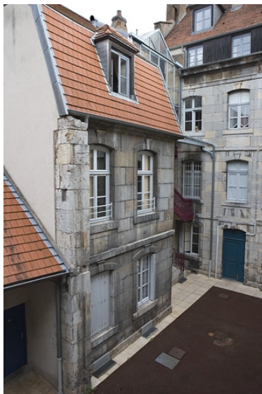
Vue d'ensemble de l'aile droite depuis le fond de la cour. Phot. Yves Sancey IVR43_20092501306NUC2A
