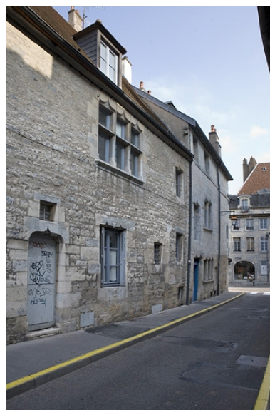
Façade latérale gauche : vue partielle. Phot. Yves Sancey IVR43_20092501298NUC2A
