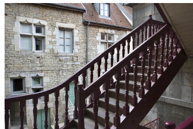
Escalier à cage ouverte sur cour, détail d'une volée. Phot. Yves Sancey IVR43_20092501309NUC2A
