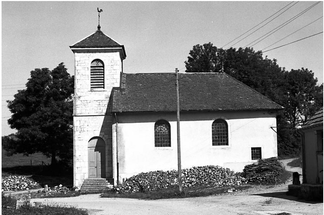
Vue de la façade latérale droite.
