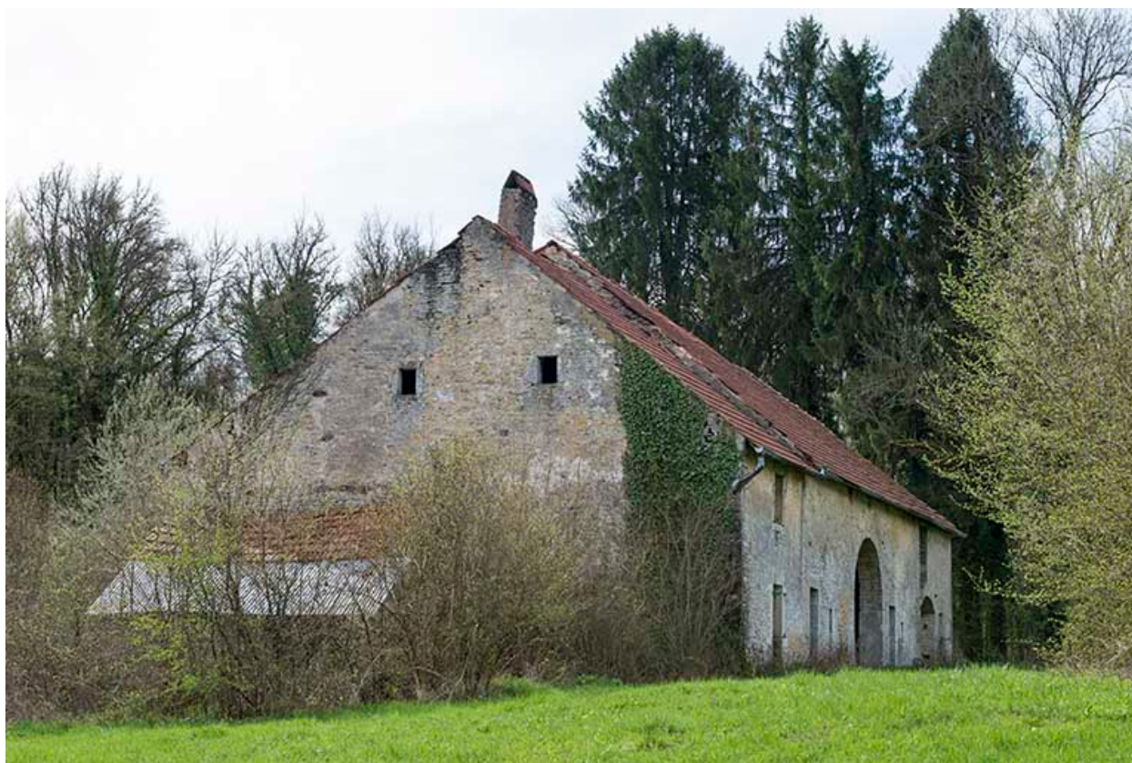
Le mur pignon nord.
