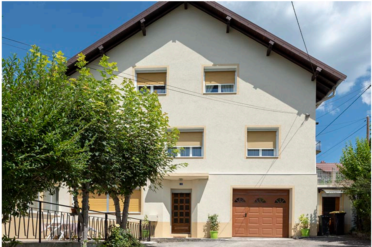
Maison : façade antérieure.
