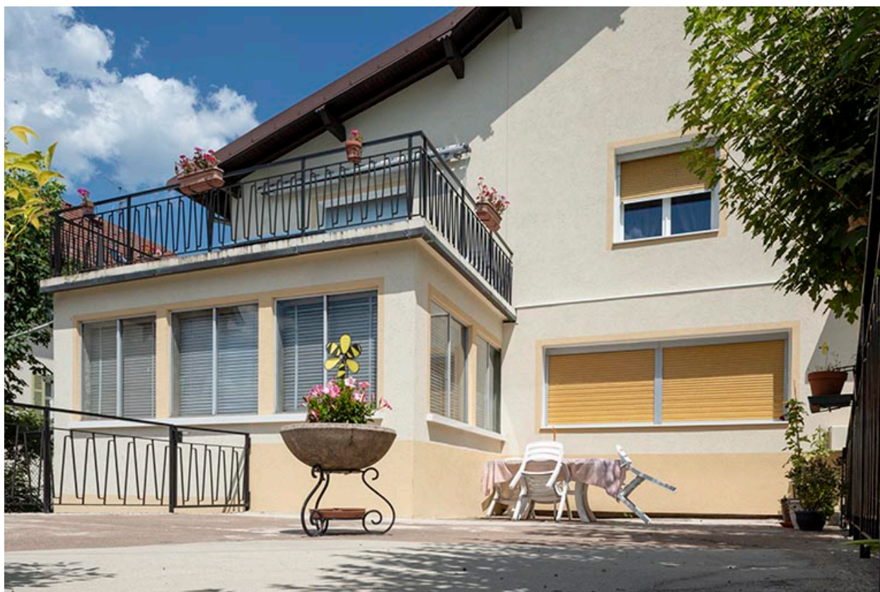
Maison et extension.
