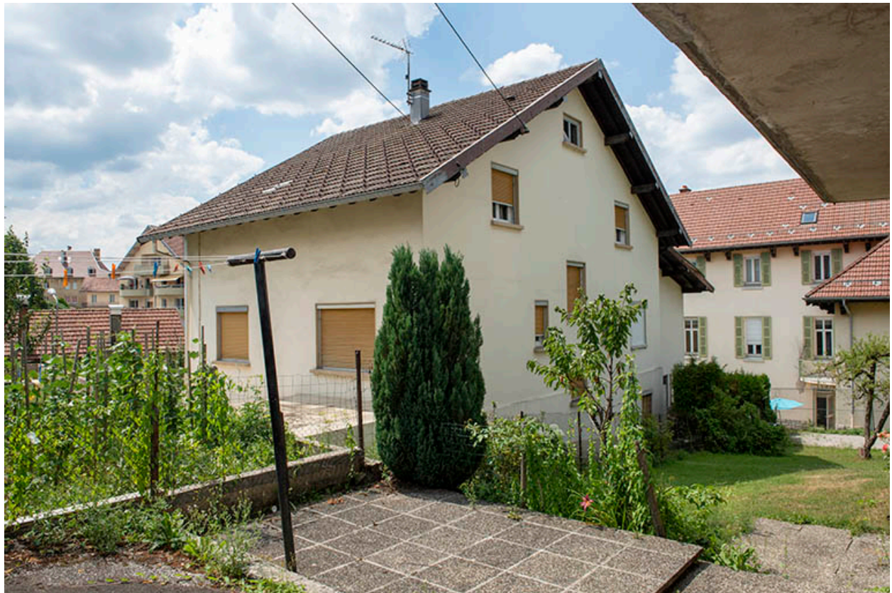
Maison : façades postérieure et latérale droite.
