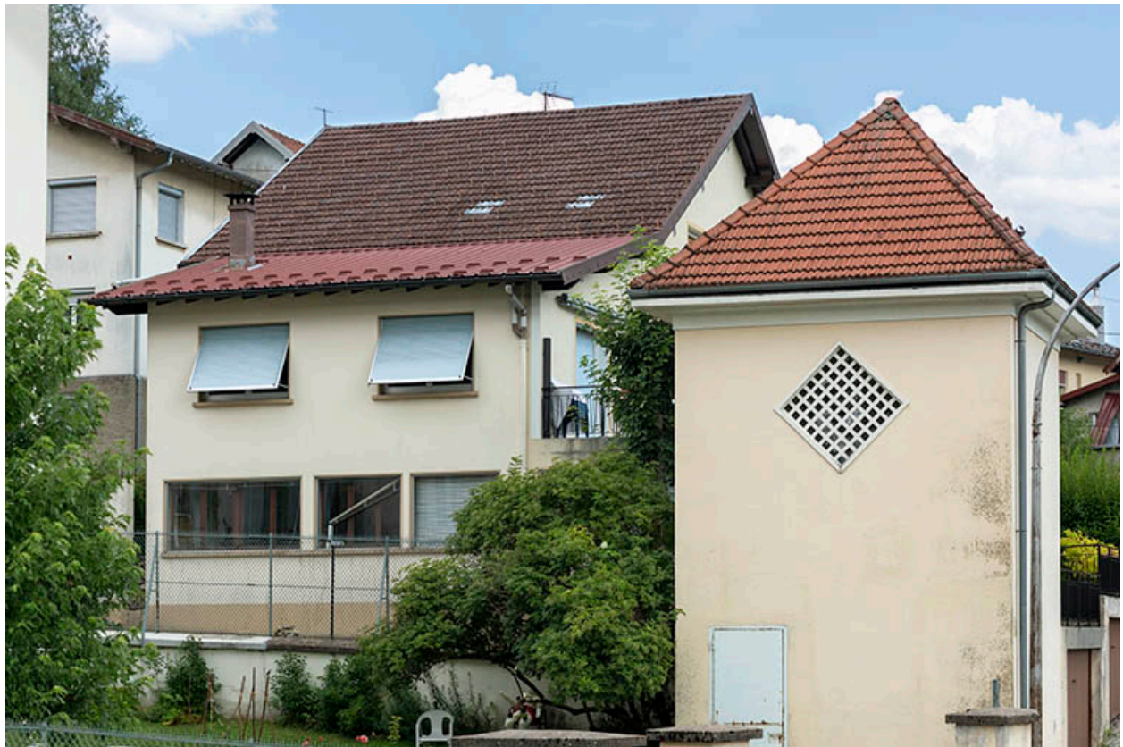
Extension occidentale avec atelier.
