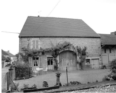
Façade antérieure. Phot. Dominique Dominguez IVR43_19773900024X
