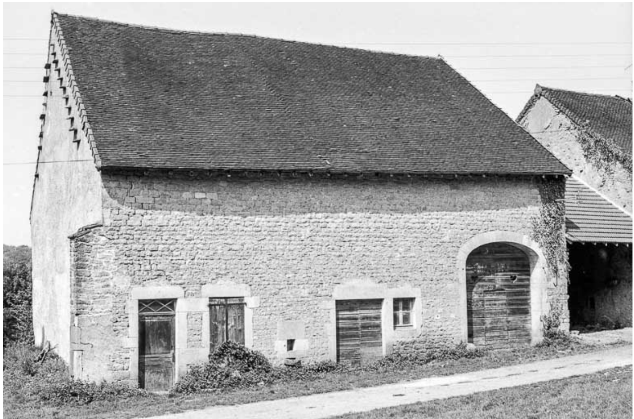
Ferme cadastrée ZK 35 : façade antérieure.
