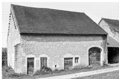
Ferme cadastrée ZK 35 : façade antérieure. Phot. Bernard Pontefract IVR43_19763900333Z
