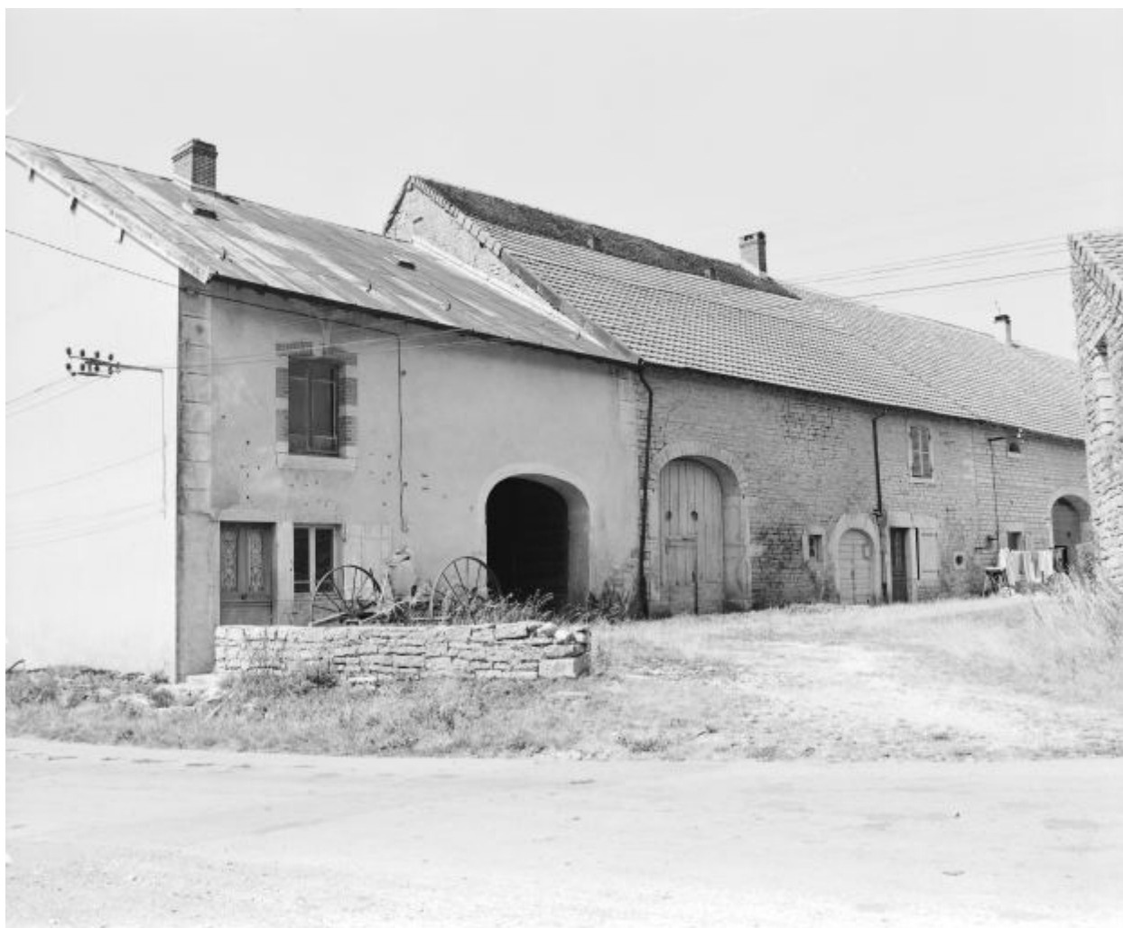
Ferme située rue de Saintaine : façade antérieure.
