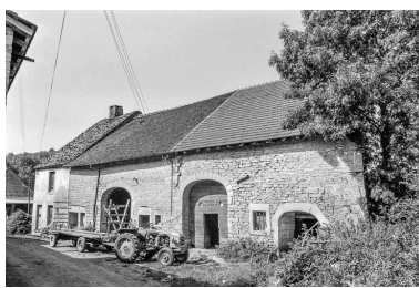
Ferme cadastrée ZK 40 : façade antérieure. Phot. Bernard Pontefract IVR43_19763900336Z
