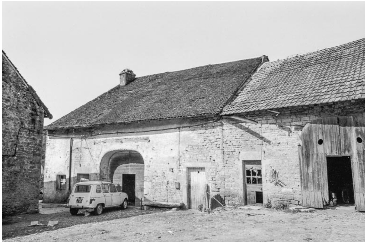
Ferme cadastrée ZK 40 : façade postérieure.
