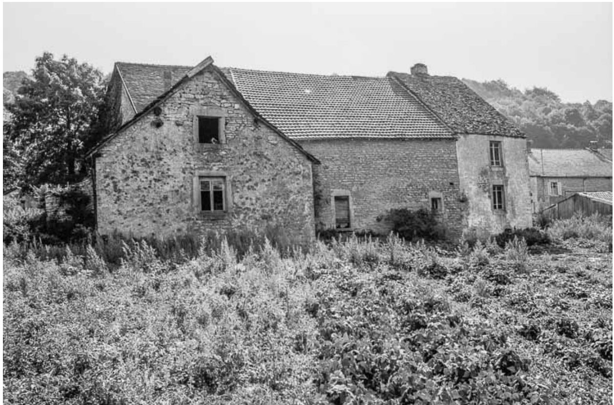
Ferme cadastrée ZK 40 : façade postérieure.
