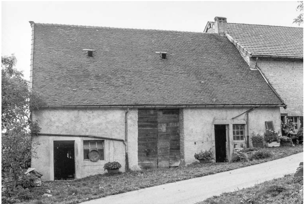
Ferme cadastrée A3 447 : façade antérieure.
