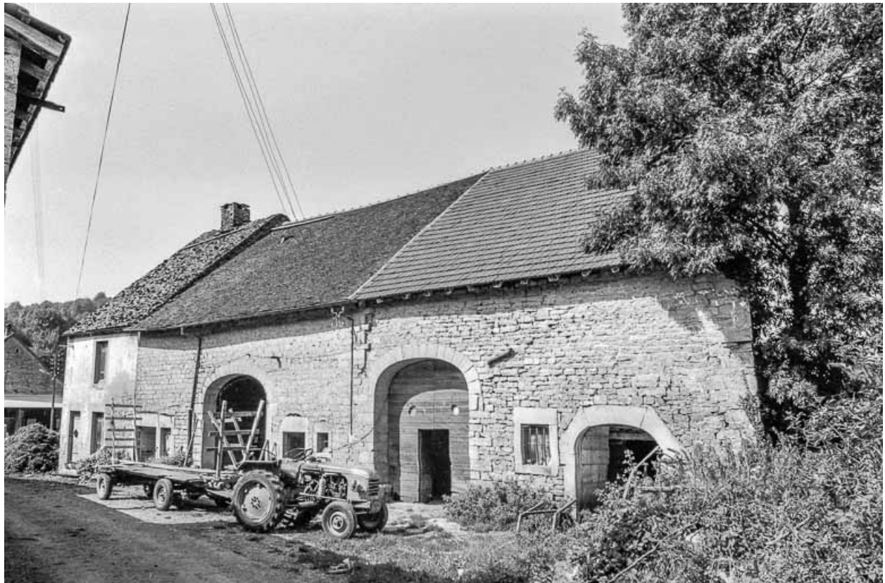
Ferme cadastrée ZK 40 : façade antérieure.
