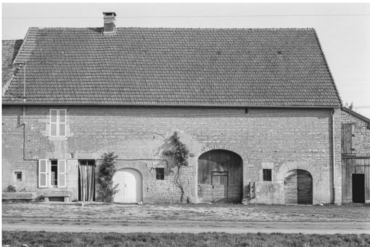
Ferme cadastrée A3 564 : façade antérieure.
