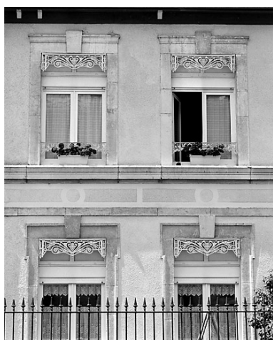
Elévation antérieure : baies. Phot. Yves Sancey IVR43_20033900117X
