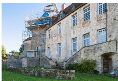
Façade nord Phot. Jérôme Mongreville IVR43_20137000397NUCA
