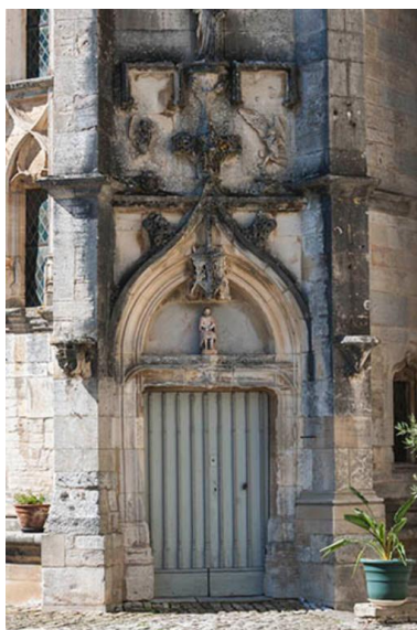
Porte d'entrée de la tour d'escalier Phot. Jérôme Mongreville IVR43_20137000371NUCA
