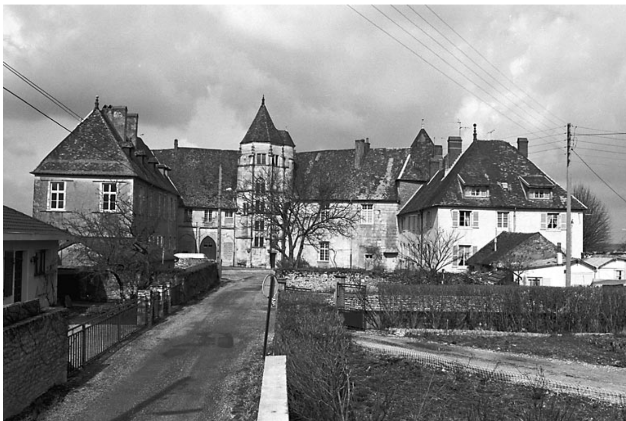
Façade antérieure sur cour
