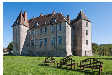
Vue générale nord-ouest Phot. Jérôme Mongreville IVR43_20137000396NUCA
