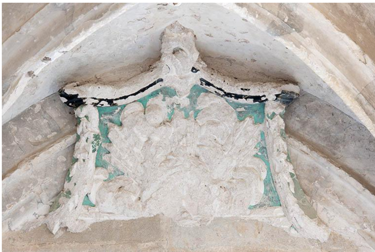
Décor de stuc situé sous la galerie
