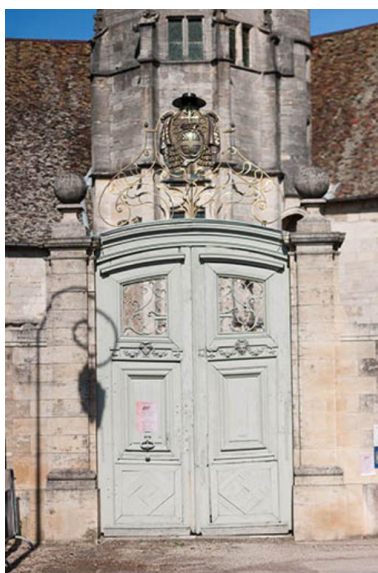
Le portail d'entrée Phot. Jérôme Mongreville IVR43_20137000411NUCA
