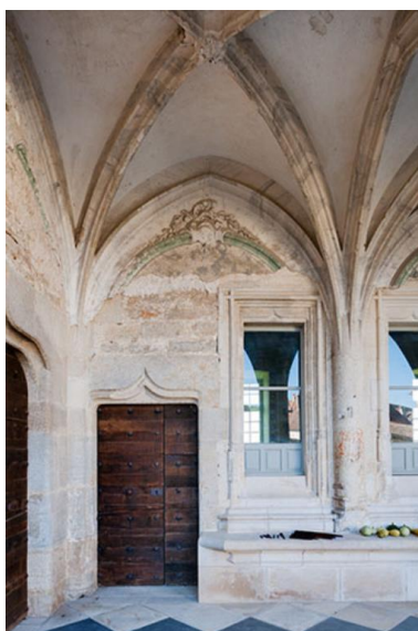
Baies situées au fond de la galerie Phot. Jérôme Mongreville IVR43_20137000403NUCA
