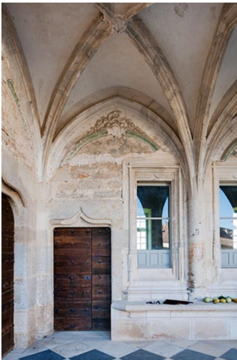
Baies situées au fond de la galerie
