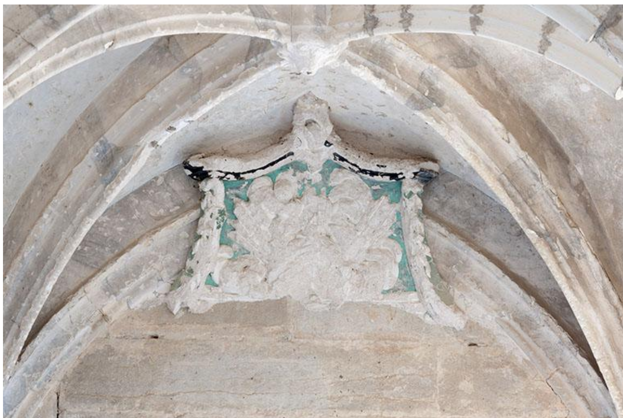
Décor de stuc situé sous la galerie
