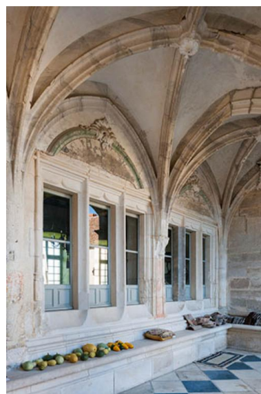
Baies situées au fond de la galerie Phot. Jérôme Mongreville IVR43_20137000404NUCA
