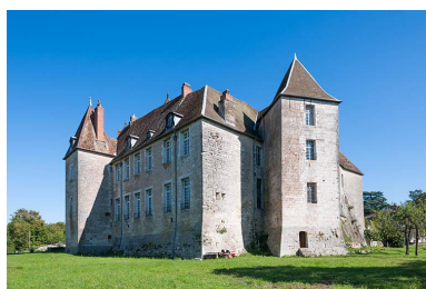
Vue générale nord-ouest Phot. Jérôme Mongreville IVR43_20137000394NUCA
