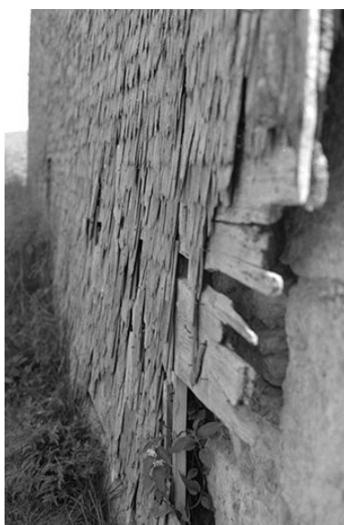
Ferme datée de 1870, située 5 rue de la Grande Fontaine : tavaillons sur le pignon gauche. Phot. Gilbert Poinot IVR43_19752501017Z
