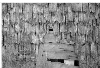
Ferme datée de 1870, située 5 rue de la Grande Fontaine : tavaillons sur le pignon gauche. Phot. Gilbert Poinot IVR43_19752501016Z
