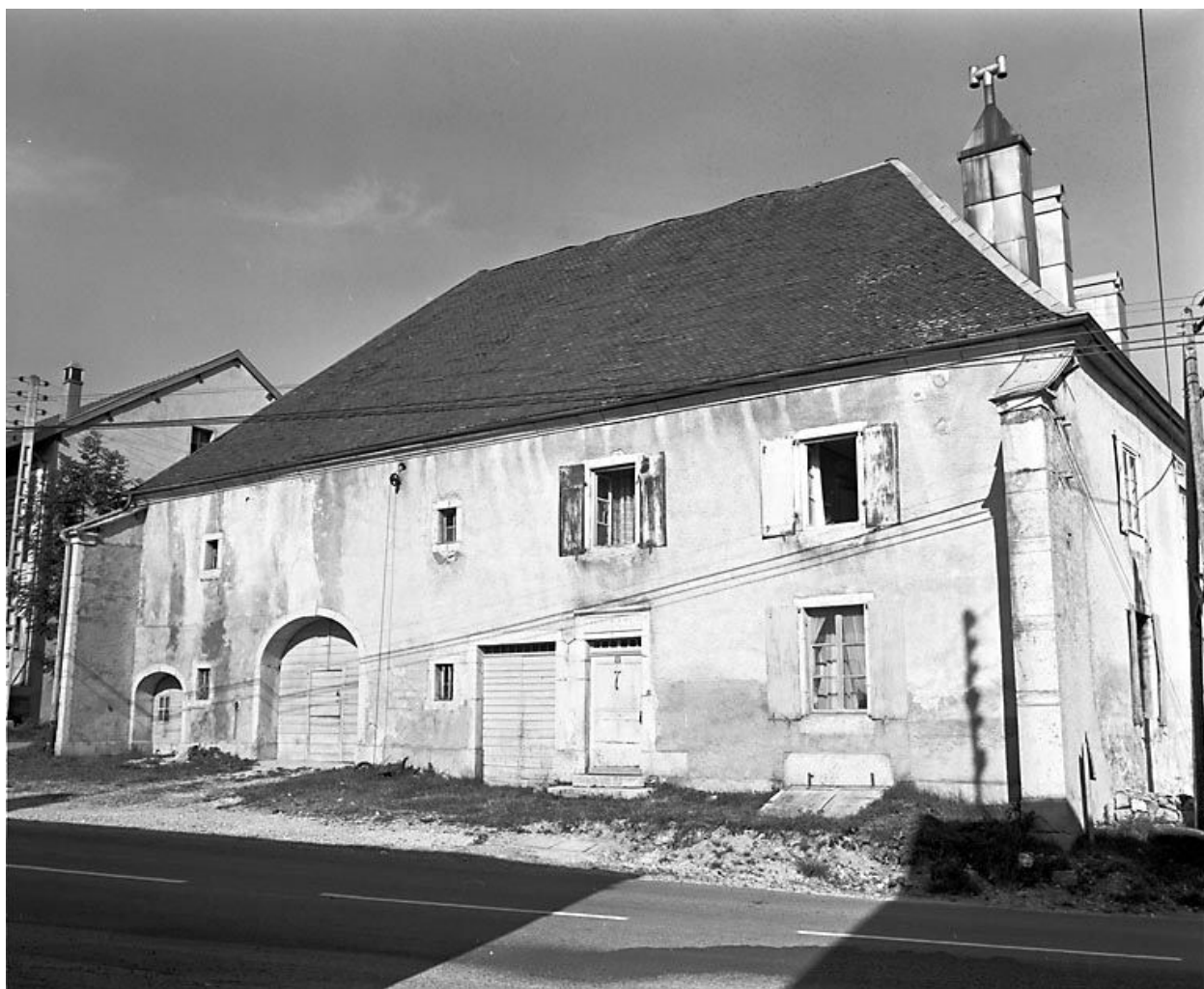
Ferme située 7 rue de la Grande Fontaine : façades antérieure et latérale droite.
