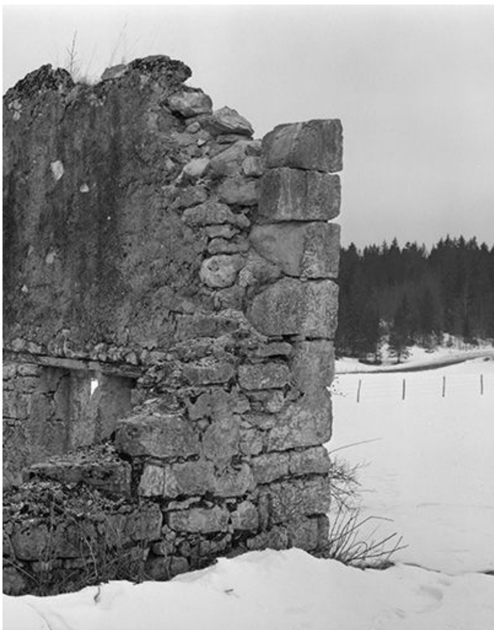
Ruine d'une ferme située au lieudit Les Cerclevaux : la chaîne d'angle et lemur.
