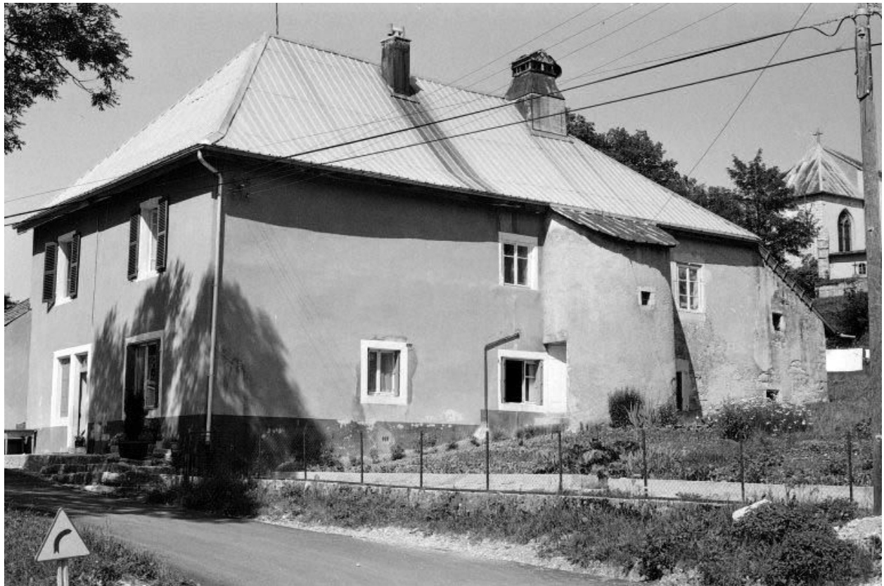
Ferme située rue de l'Eglise : façades antérieure et latérale droite.
