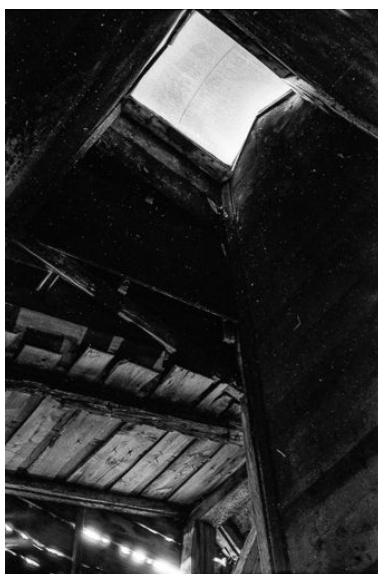
Ferme de 1750, située au lieudit Le Pré Poncet : "tué" vu de l'intérieur. Phot. Gilbert Poinot IVR43_19752501061Z
