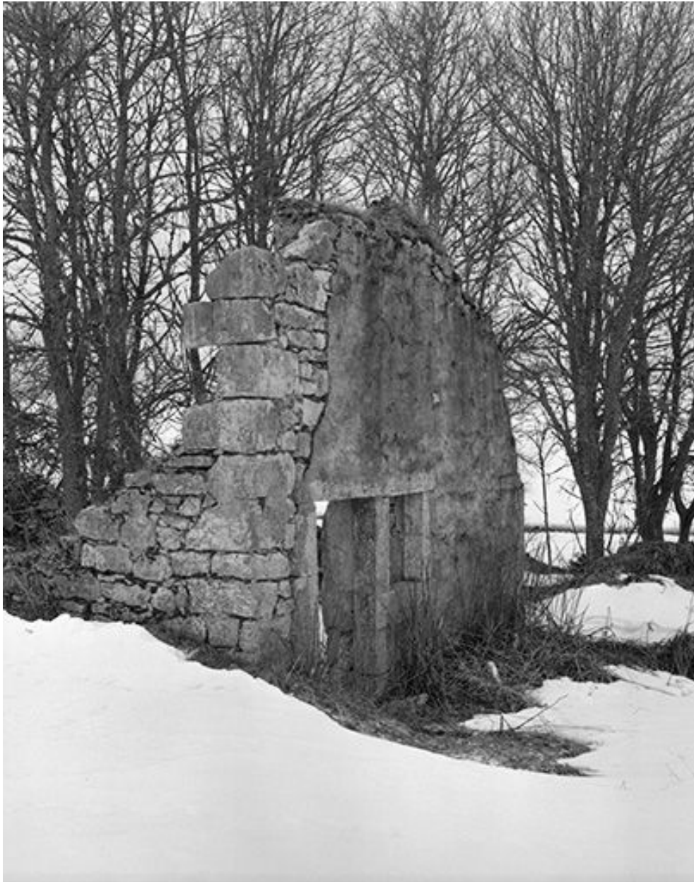
Ruine d'une ferme située au lieudit Les Cerclevaux : la chaîne d'angle.
