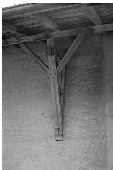
Ferme de 1818, située 11 Grande Rue : extrémité de la pièce de bois doublant le chevron-arbalétrier. Phot. Gilbert Poinot IVR43_19752501008Z
