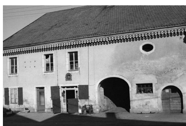
Ferme de 1865, située 12 Grande Rue : façade antérieure.
