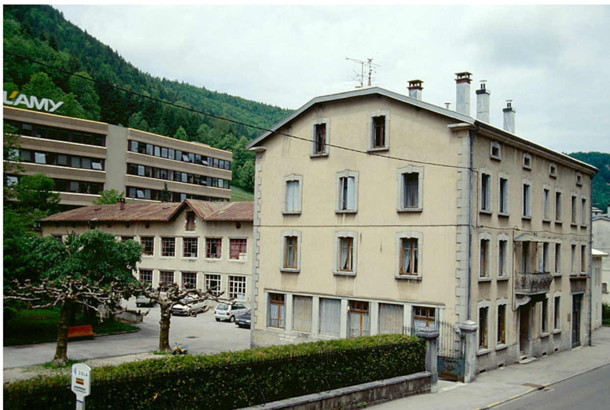
Logement patronal et atelier de fabrication.
