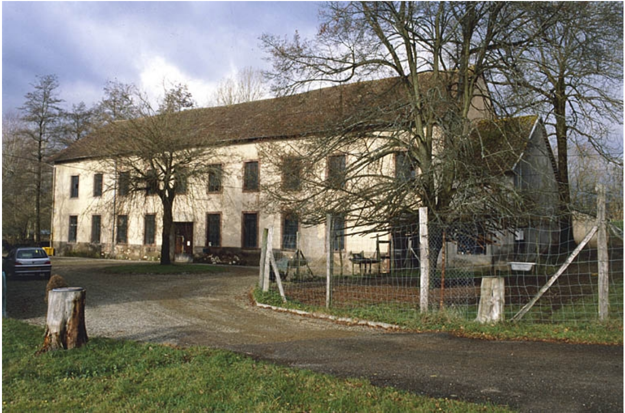
Façade antérieure de l'atelier de fabrication.
