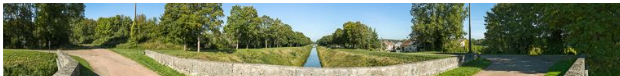
Vue panoramique de la tranchée.
