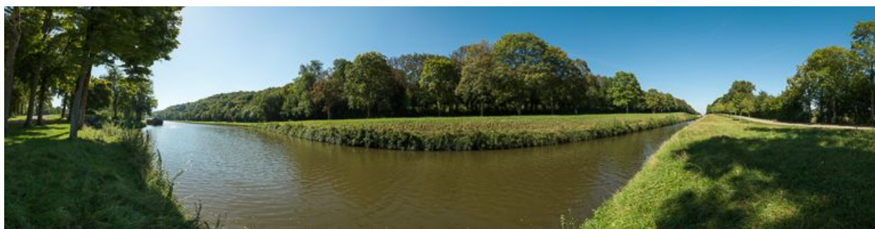
Panorama de l'entrée de la tranchée.
