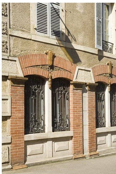
Travée à fenêtre double Phot. Jérôme Mongreville IVR43_20097000185NUC2A
