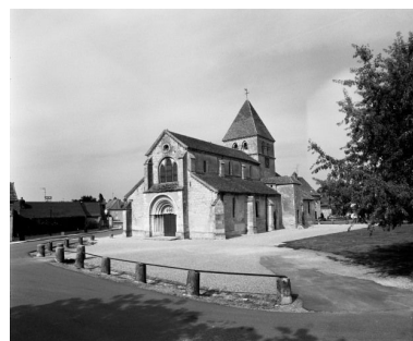
Vue d'ensemble : façade et élévation droite.
