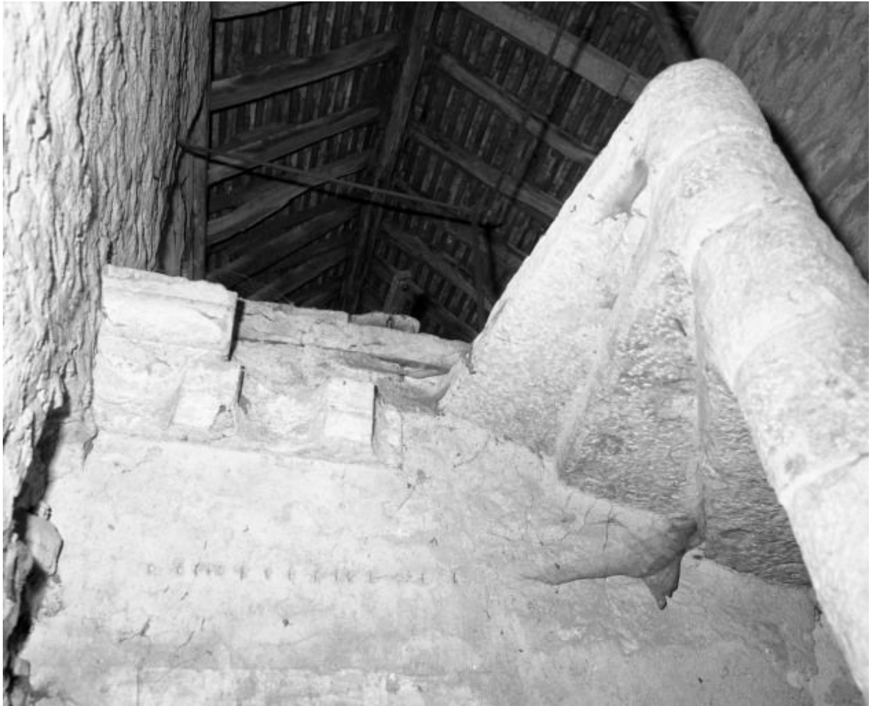
Vestige de corniche du bas-côté droit visible dans la tourelle d'escalier du clocher.
