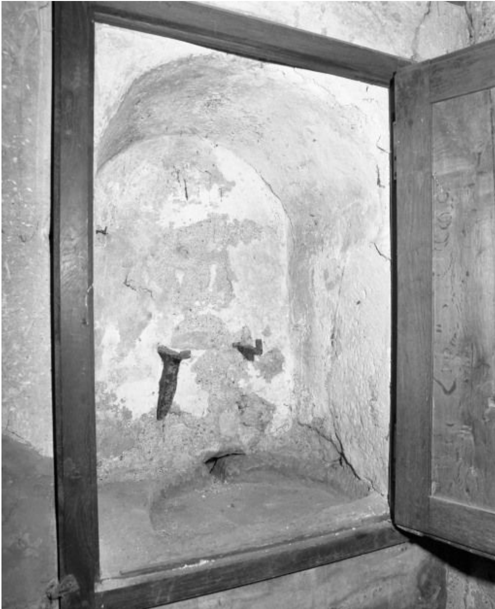
Sacristie, lavabo à l'intérieur du placard (mur sud).
