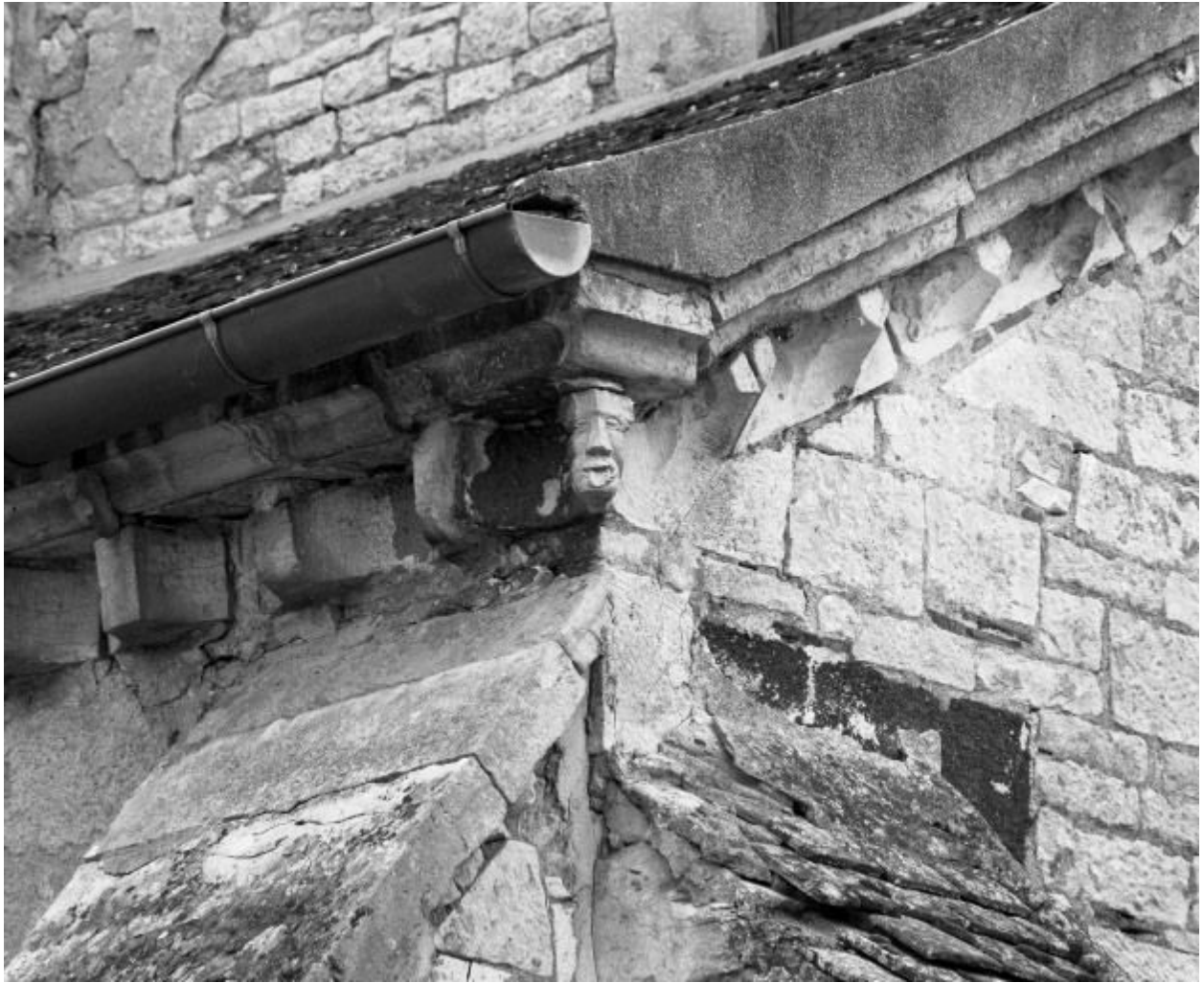
Façade : détail de l'angle du bas-côté gauche.
