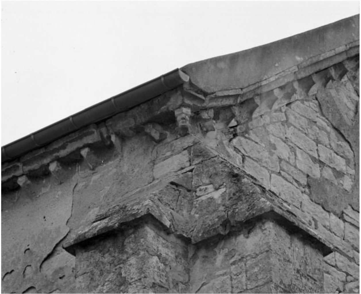
Façade : détail de l'angle gauche du pignon.
