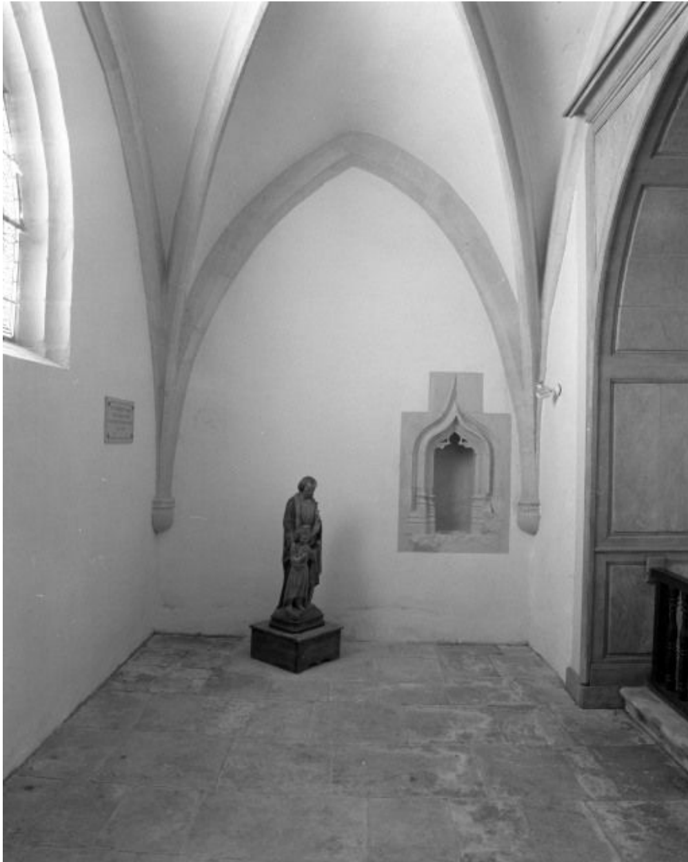
Chapelle gauche du chœur, partie postérieure.
