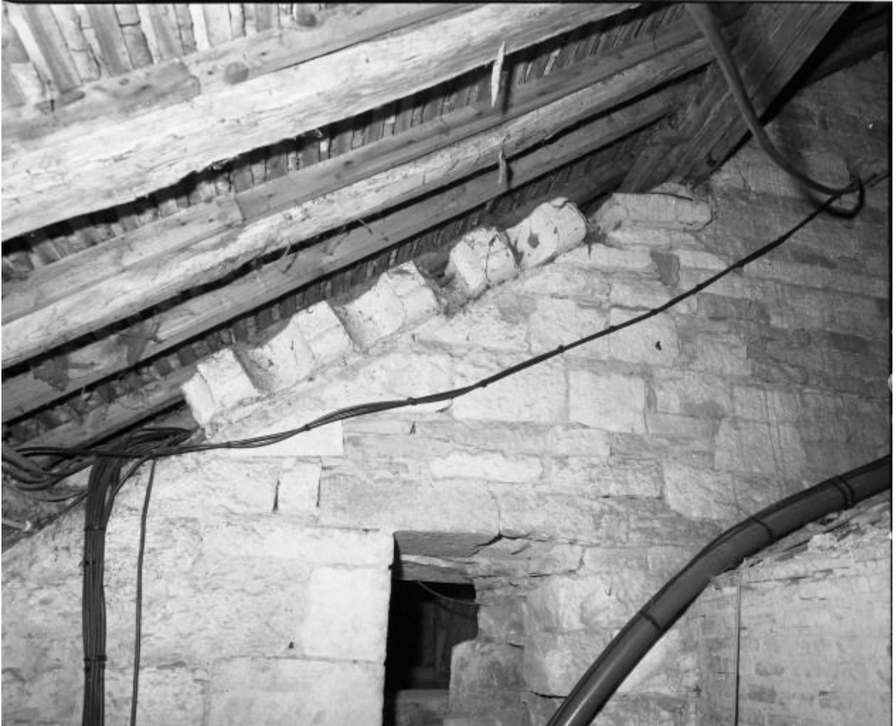
Partie supérieure du rampant du bas-côté droit, vue prise du comble de la sacristie.
