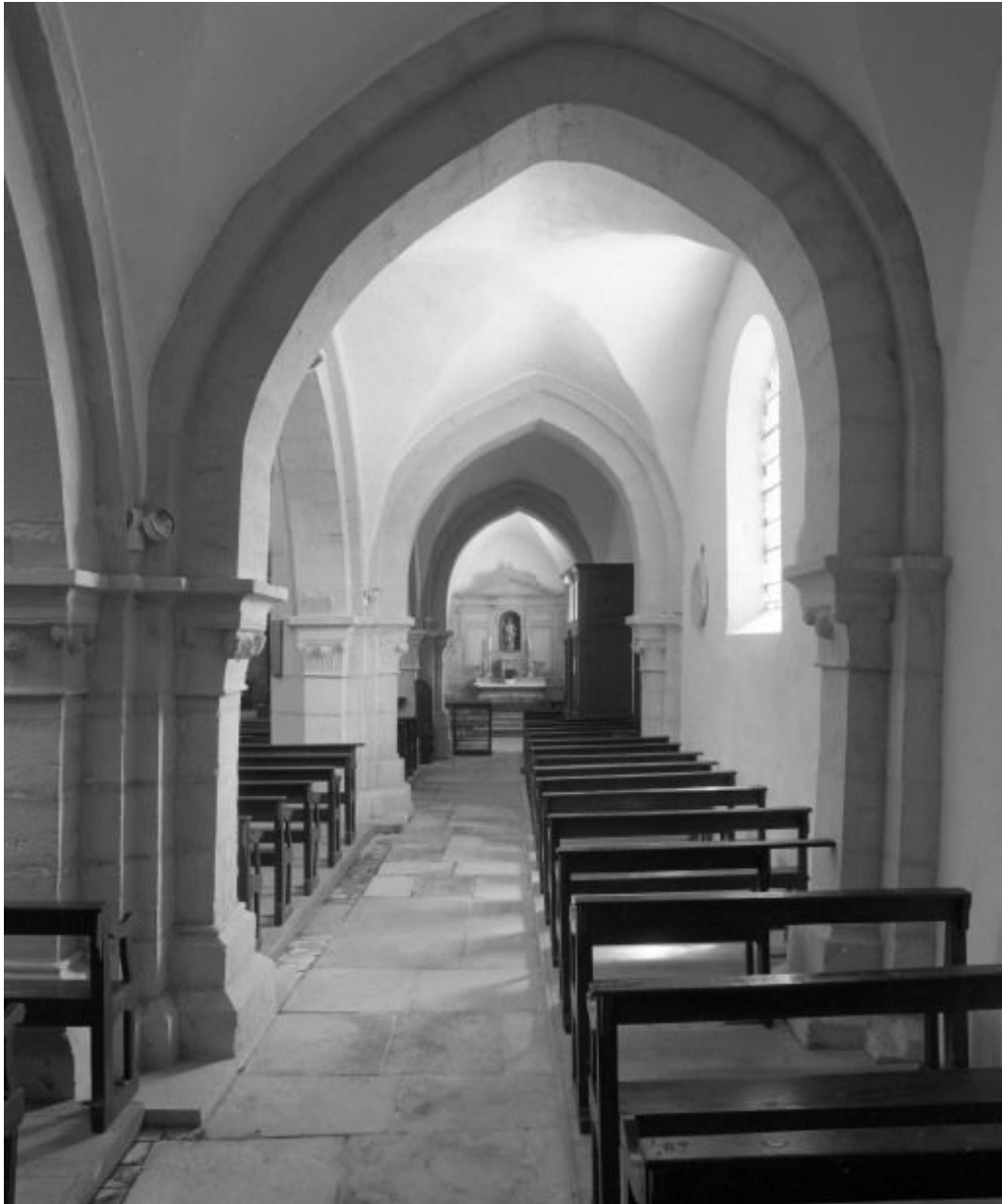
Bas-côté droit, vue prise depuis la première travée.
