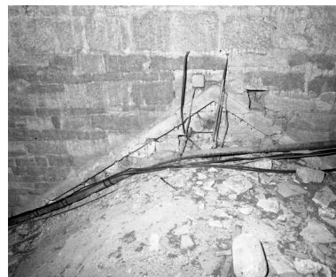
Rampants du pignon de l'ancien toit du choeur contre le mur postérieur du clocher. Vue prise dans le comble du choeur. Phot. Michel Rosso IVR26_20037101579X
