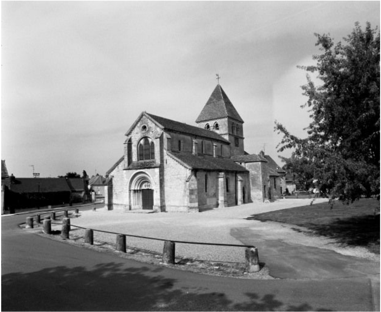
Vue d'ensemble : façade et élévation droite.
