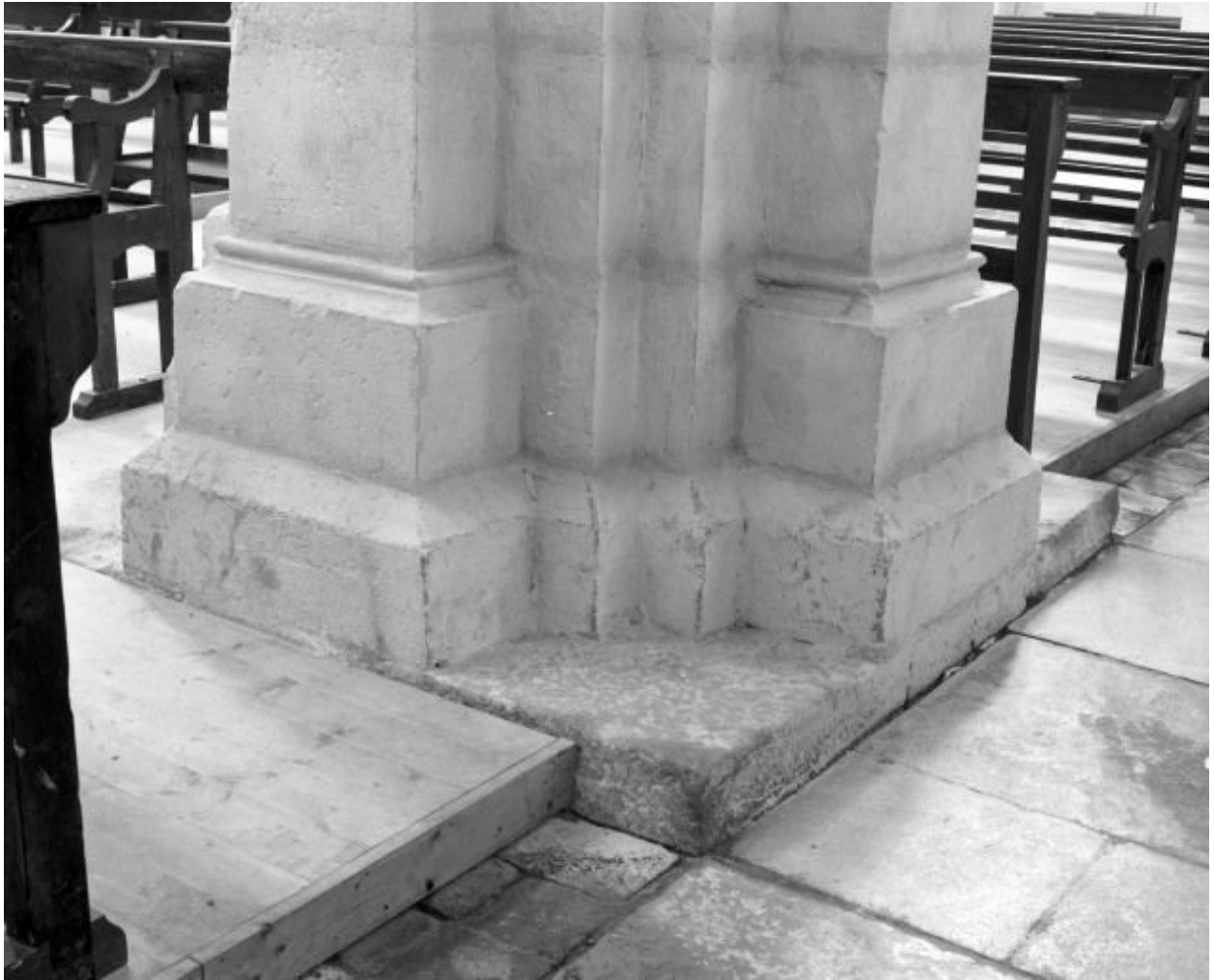
Bas-côté gauche, 3e travée, base du pilier antérieur droit (n° 24 sur le plan de localisation).
