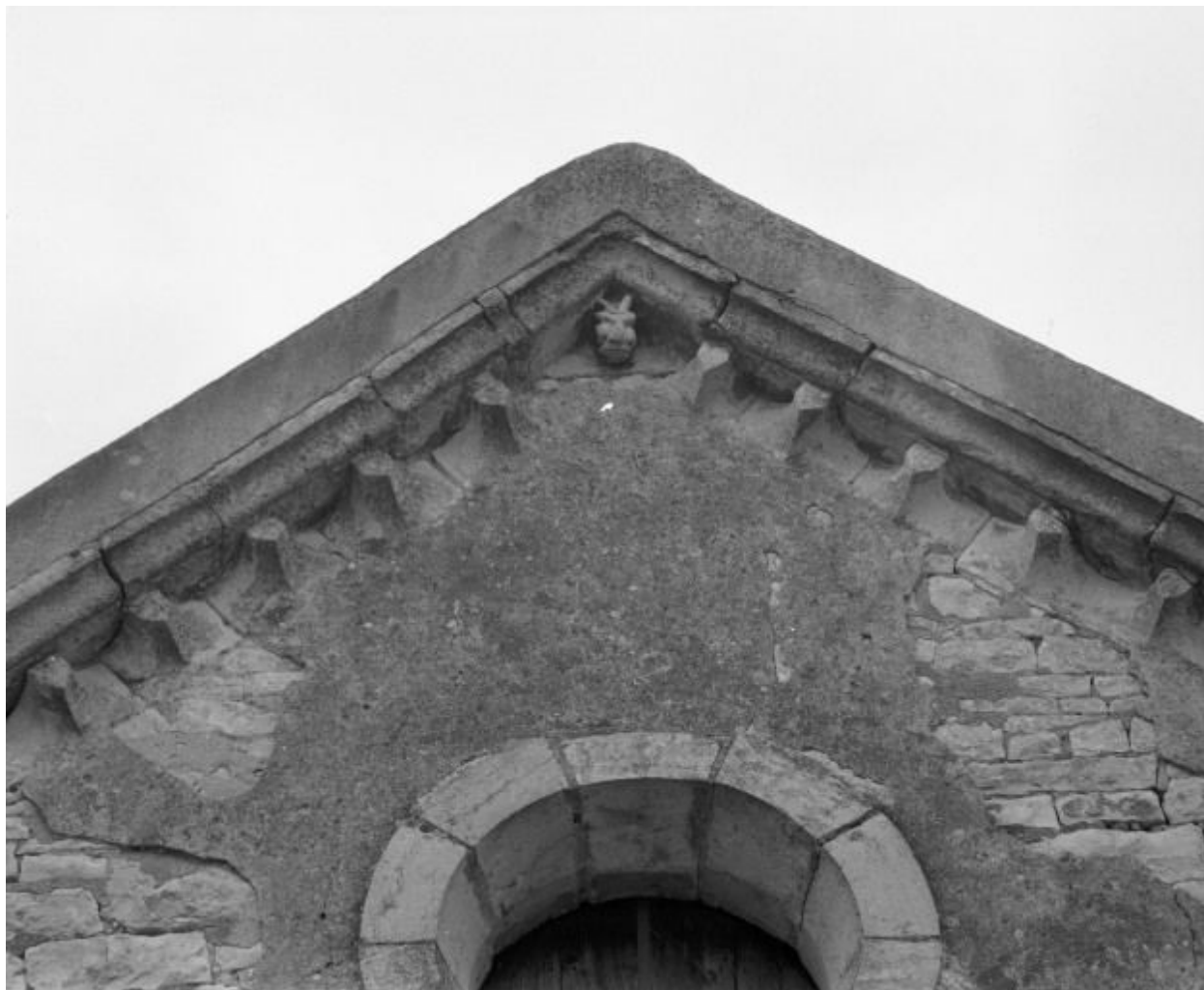
Façade : détail du pignon.
