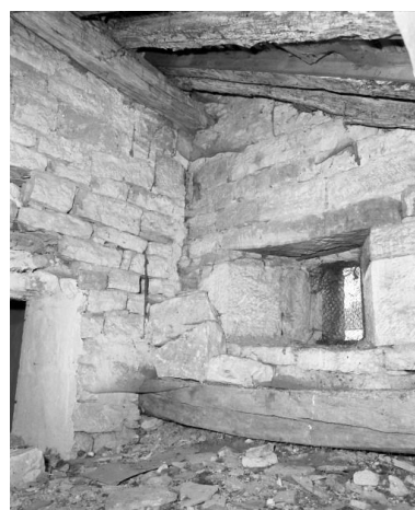
Bas-côté gauche, jour antérieur, vue prise du comble. Phot. Michel Rosso IVR26_20037101575X
