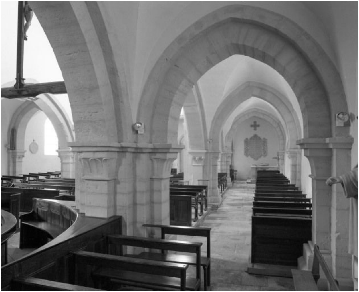
Bas-côté gauche, vue depuis sa chapelle.
