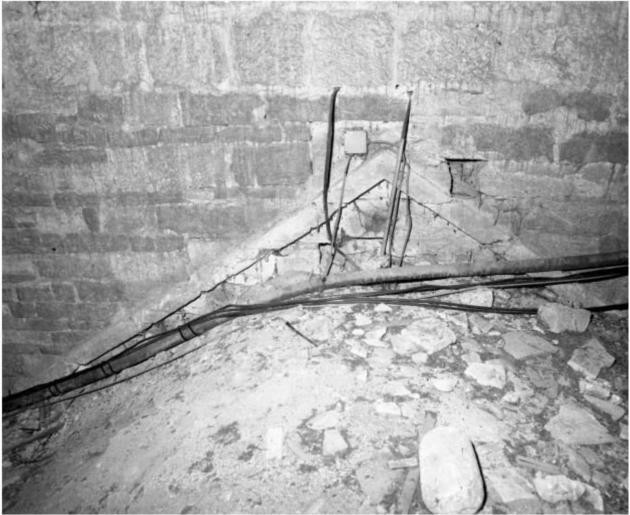
Rampants du pignon de l'ancien toit du chœur contre le mur postérieur du clocher. Vue prise dans le comble du chœur.
