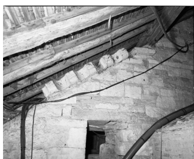
Partie supérieure du rampant du bas-côté droit, vue prise du comble de la sacristie. Phot. Michel Rosso IVR26_20037101581X
