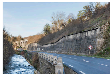
Viaduc et mur de soutènement, depuis l'est. Phot. Jérôme Mongreville IVR43_20243900014NUC4A
