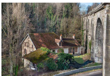
Virage et viaduc, vus de trois quarts.
