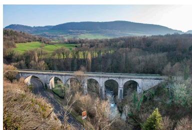
Vue du viaduc depuis le nord-ouest.
