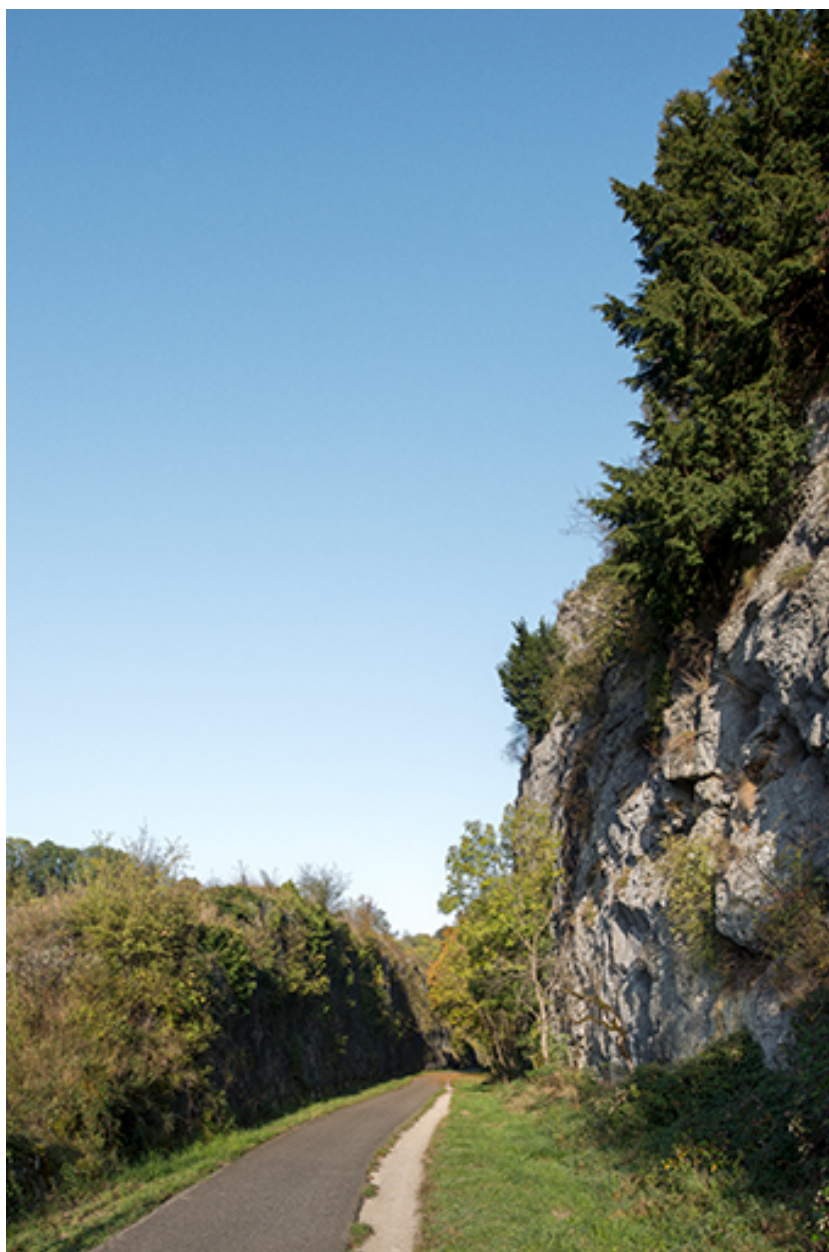
Tranchée de la voie ferrée. Vue depuis l'est.
