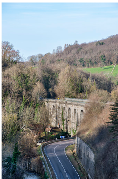
Vue rapprochée du viaduc, depuis l'est.
