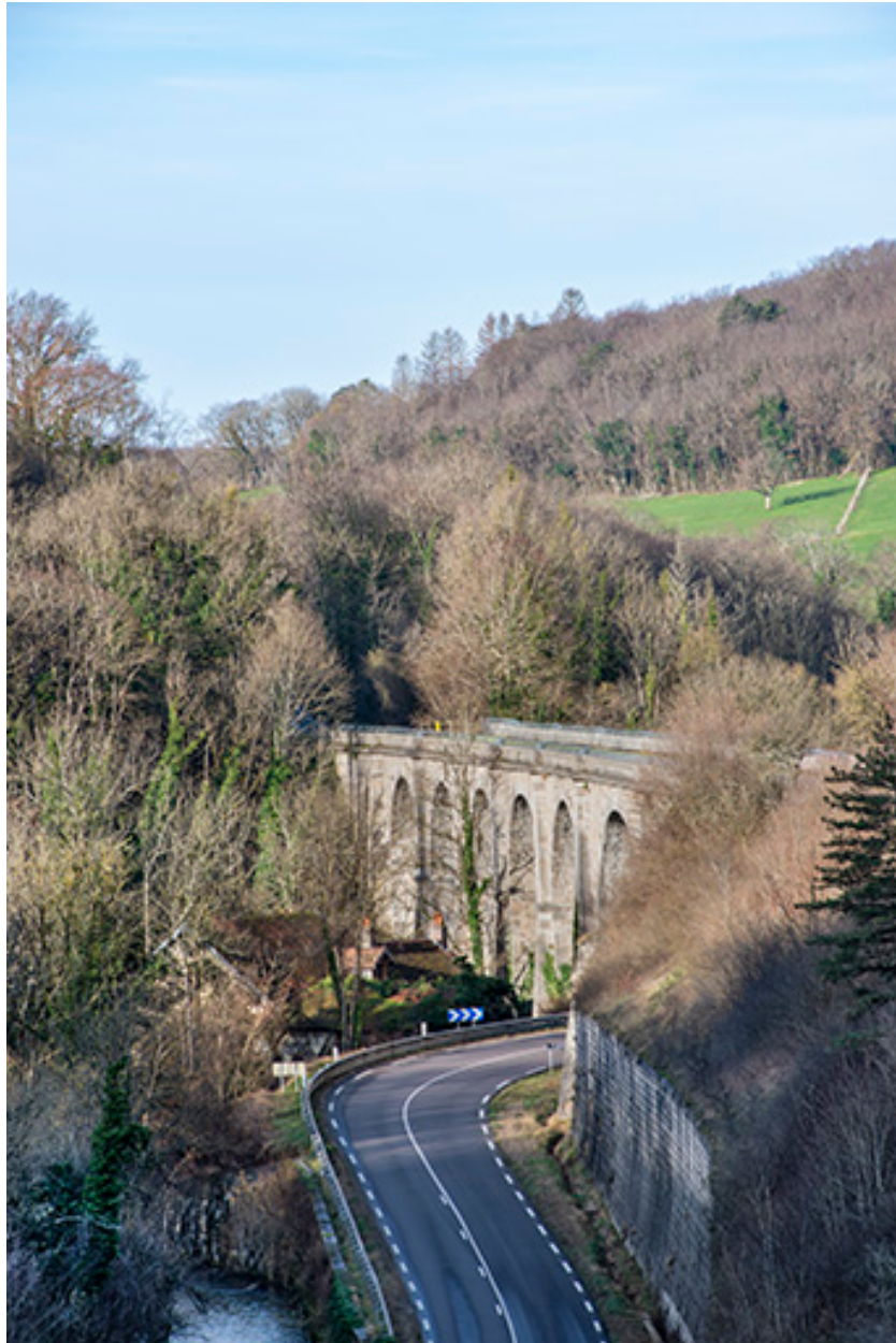
Vue rapprochée du viaduc, depuis l'est.
