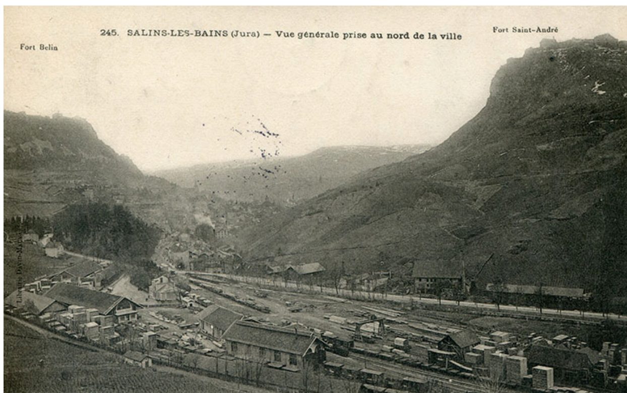
Salins-les-Bains (Jura) – Vue générale prise au nord de la ville, s.d. [fin 19e ou début 20e siècle].
