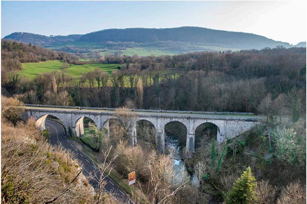
Vue du viaduc depuis le nord-ouest.
