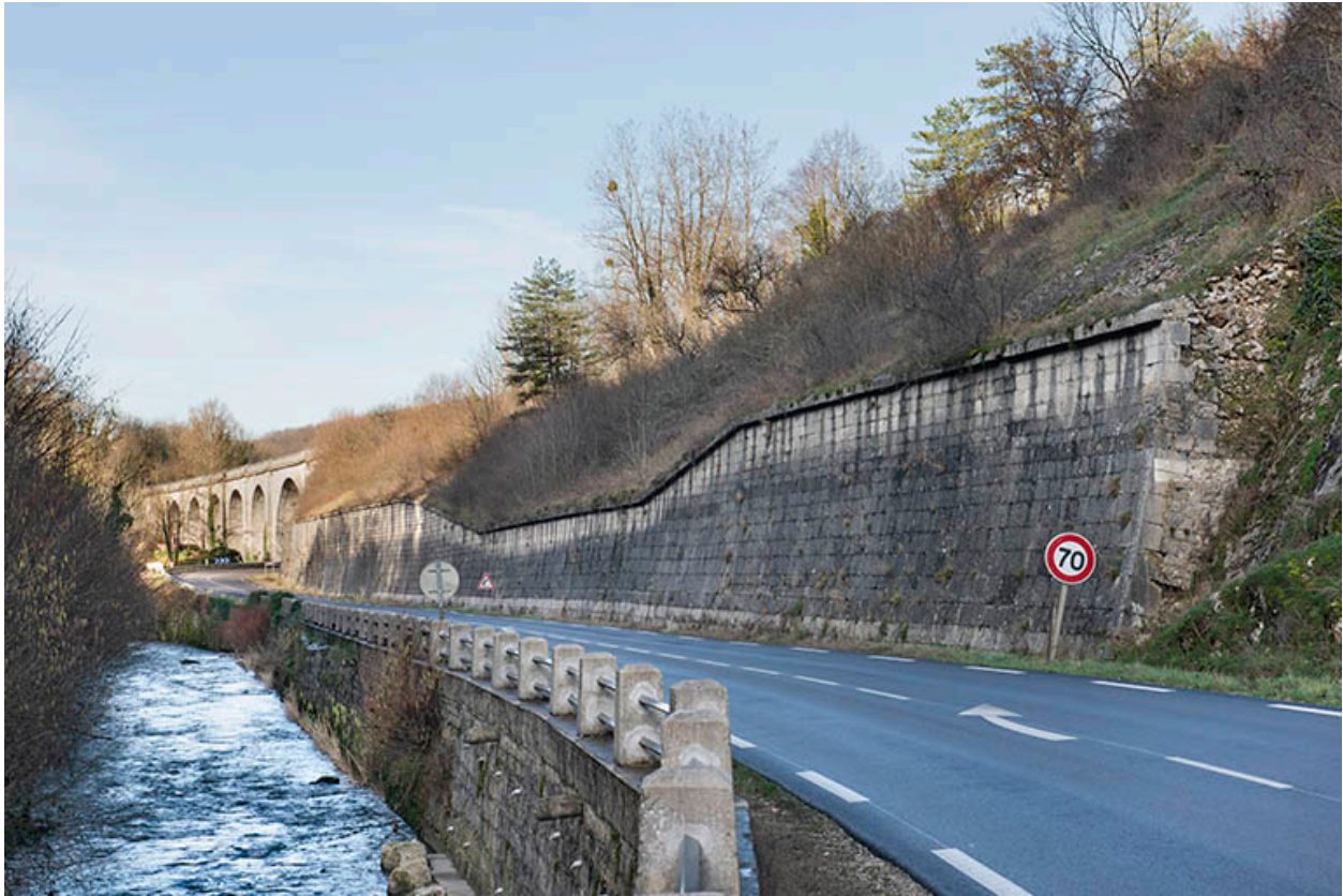
Viaduc et mur de soutènement, depuis l'est.
