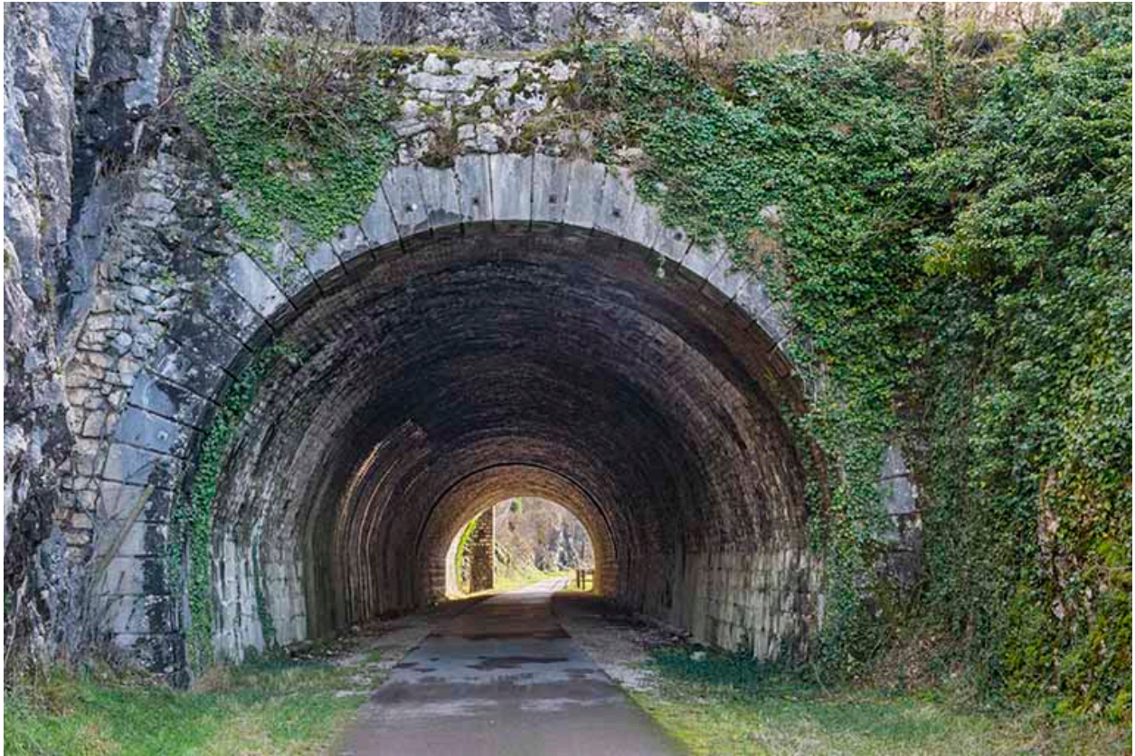
Entrée ouest du tunnel.
