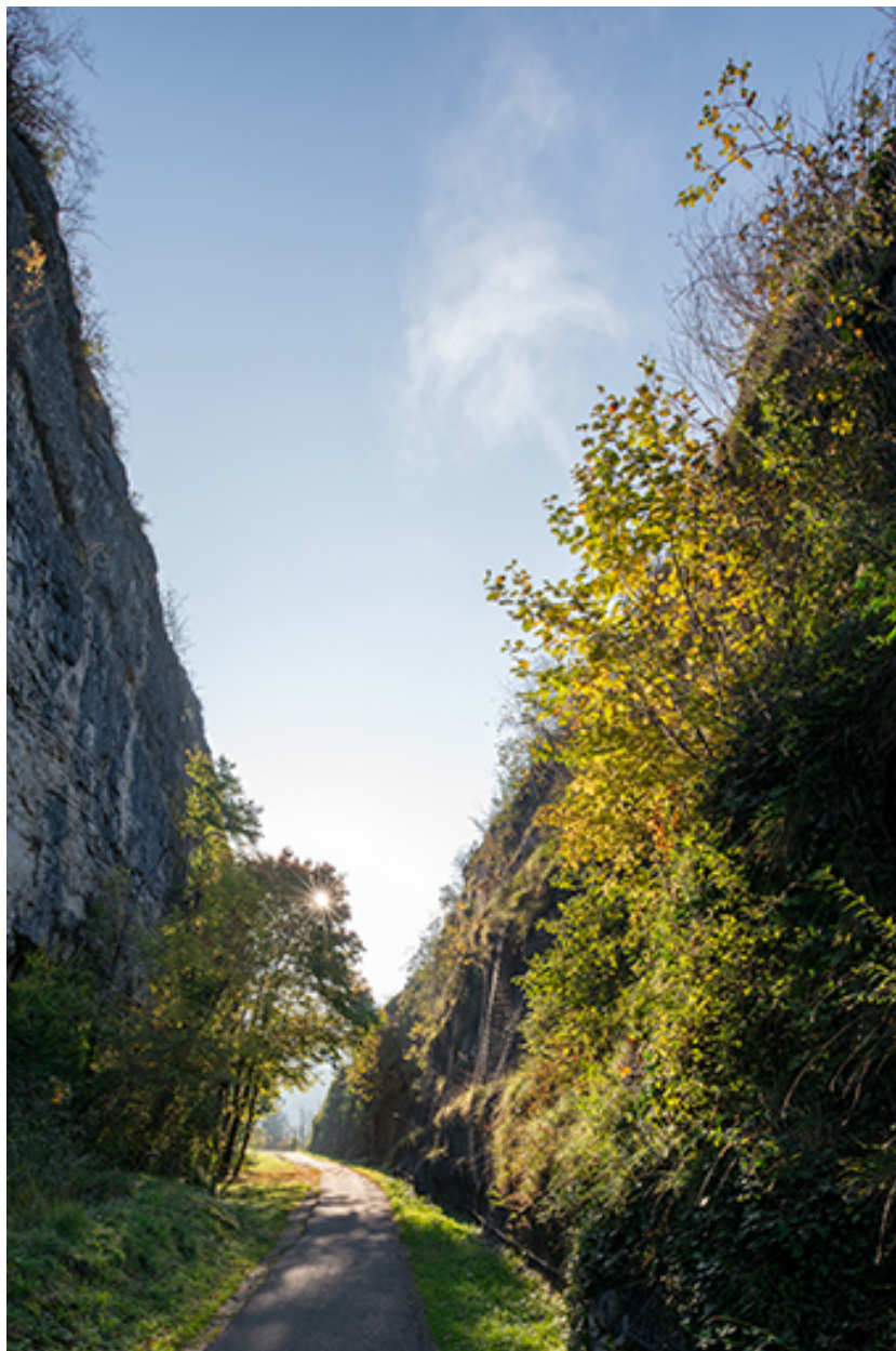
Tranchée de la voie ferrée. Vue depuis l'ouest.
