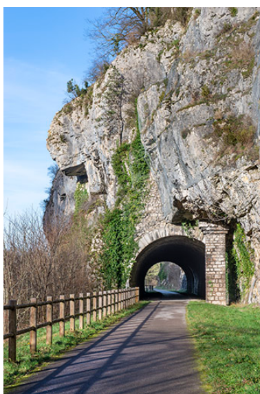
Vue du tunnel depuis l'est. Phot. Jérôme Mongreville IVR43_20243900009NUC4A
