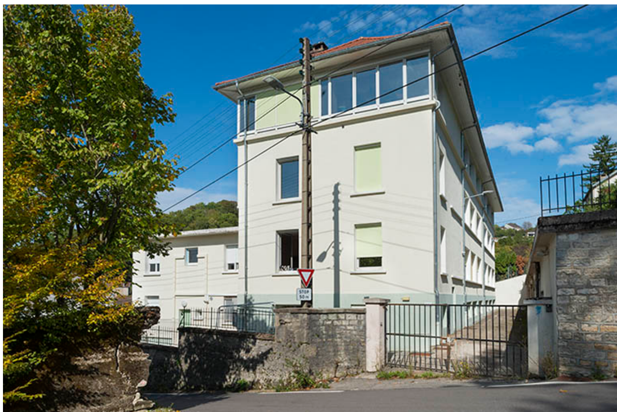
Pignon ouest et façade postérieure.
