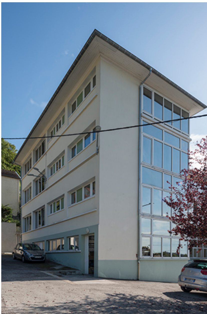
Extension de l'atelier depuis le nord.
