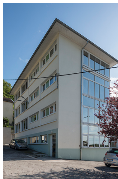
Extension de l'atelier depuis le nord. Phot. Jérôme Mongreville IVR43_20172501136NUC4A
