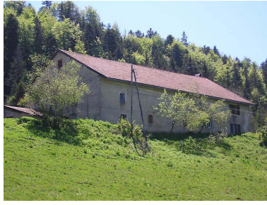
Façade postérieure. Phot. Marie-Pierre Reynet IVR43_20083900501NUC1A
