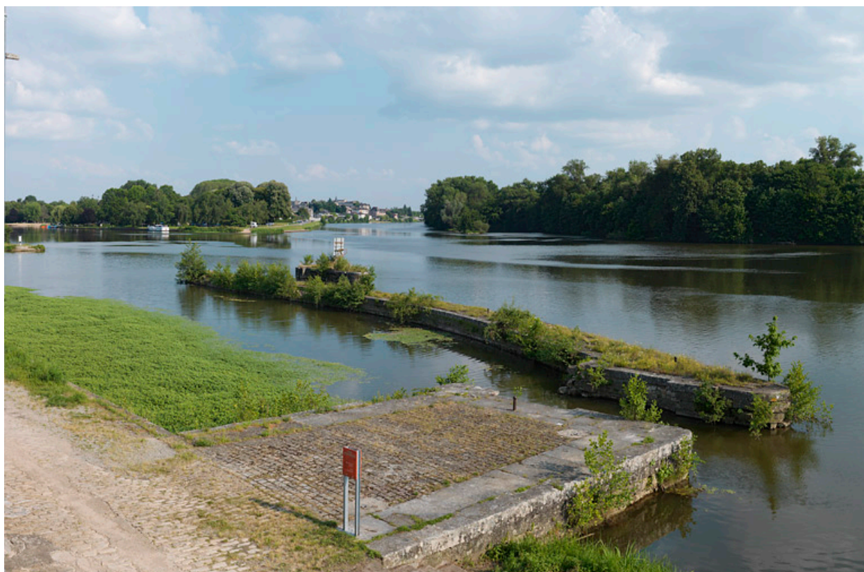
Le quai et le pertuis en maçonnerie de moellon devant le maison. En arrière-plan, la ville de Decize.
