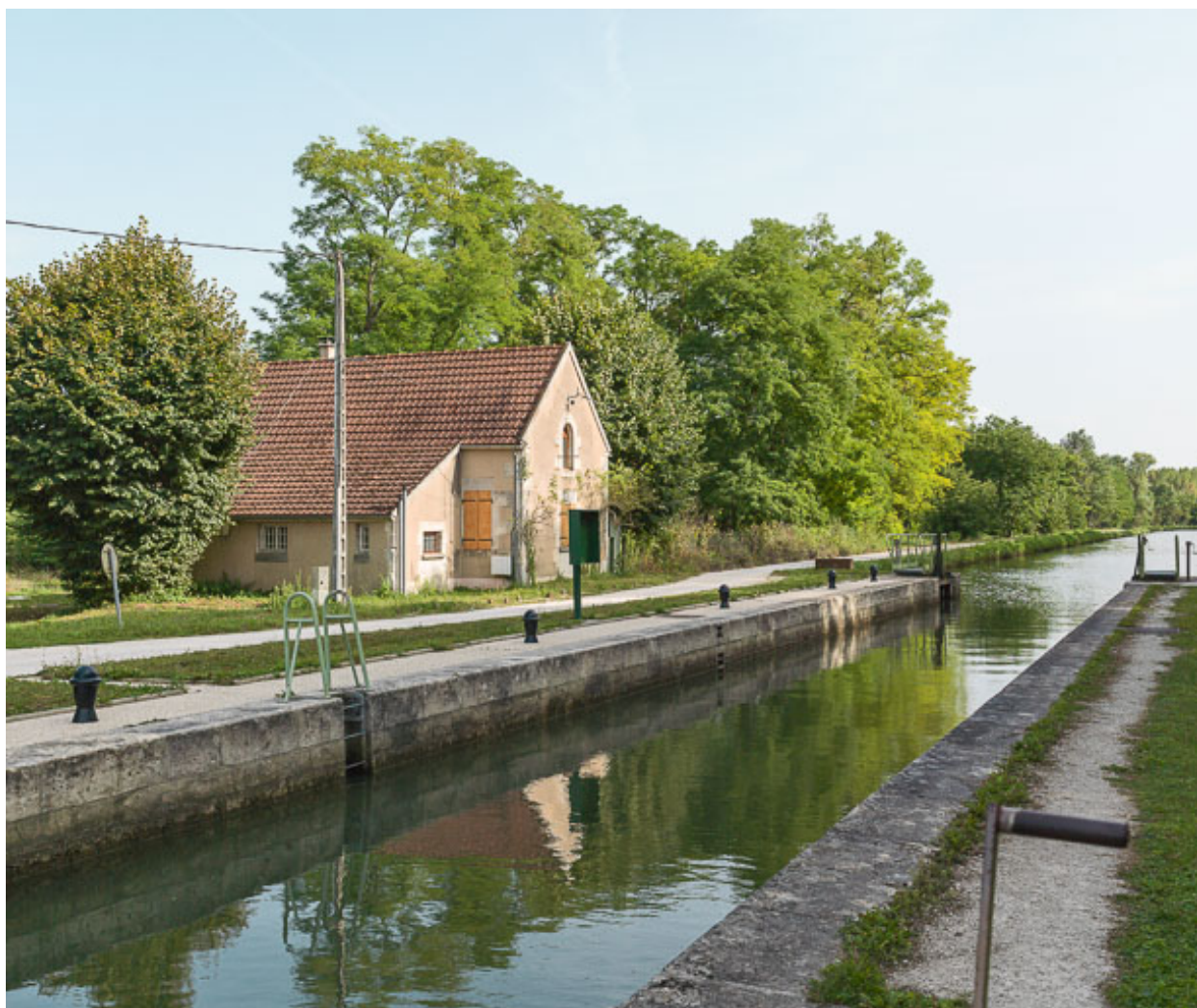
Vue du site d'écluse.
