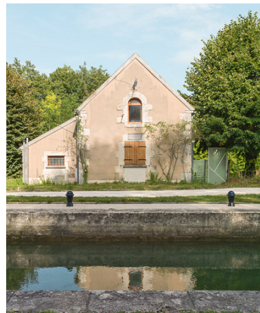
Vue de la maison éclusière. Phot. Pierre-Marie Barbe-Richaud IVR26_20178900147NUC2A
