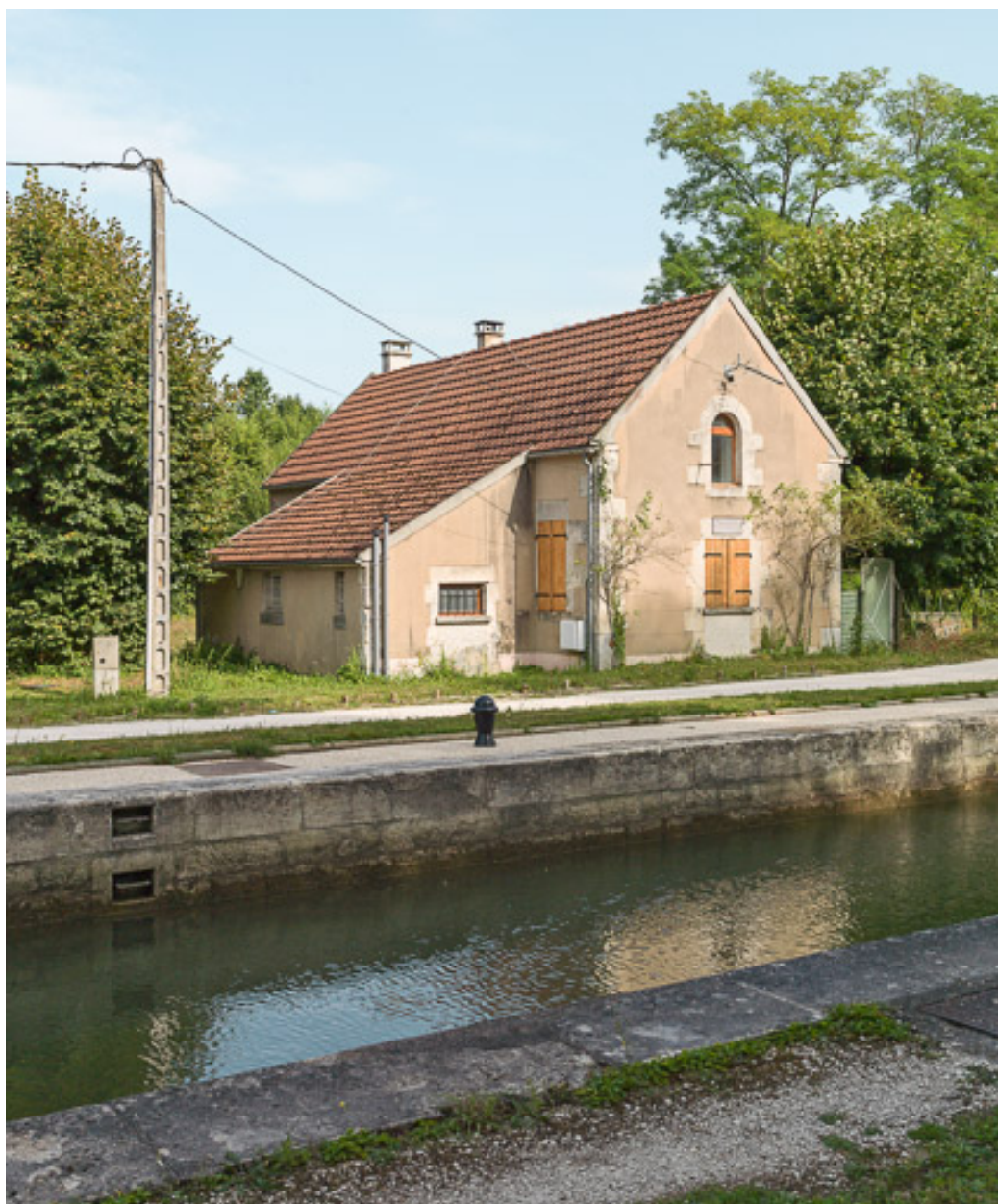
Vue de la maison éclusière.
