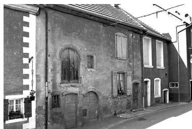
Maison de vigneron située 13 Grande Rue. Phot. Yves Sancey IVR43_19802501118X
