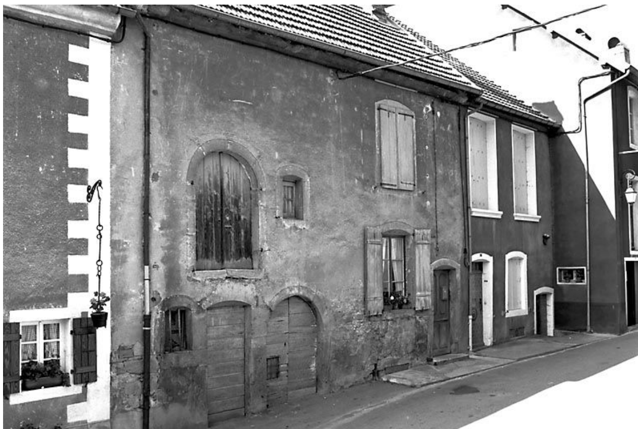
Maison de vigneron située 13 Grande Rue.
