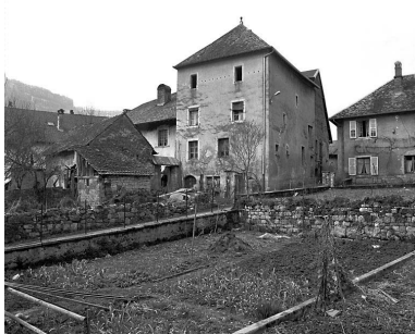
Maison de vigneron située rue de la Croix de Sompré. Phot. Yves Sancey IVR43_19822500188X
