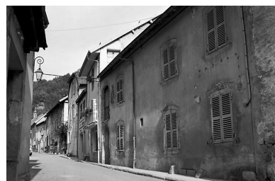
Maison de vigneron située 30 Grande Rue. Phot. Yves Sancey IVR43_19802501107X
