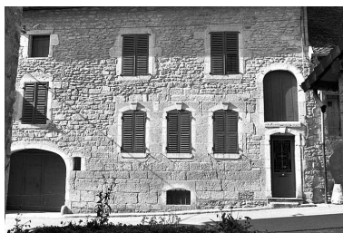
Maison de vigneron située 7 rue Robert Dame. Phot. Yves Sancey IVR43_19802501100X
