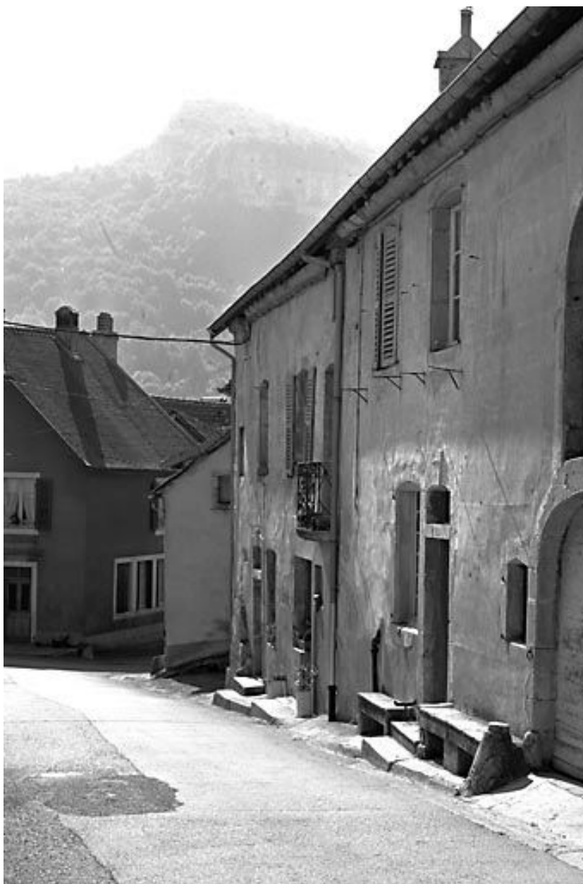
Maison de vigneron située 11 rue du Chapite.
