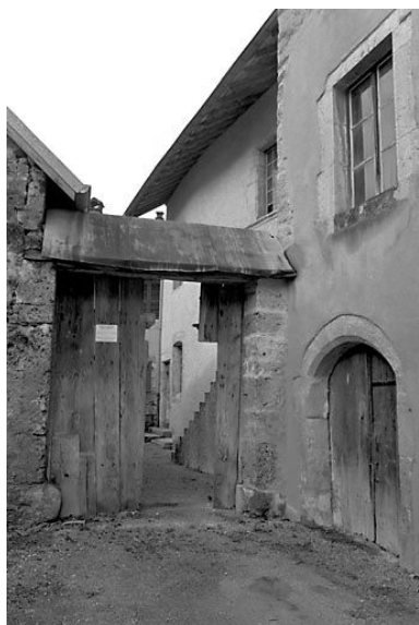
Maison située rue de la Croix de Sompré. Phot. Jérôme Mongreville IVR43_20012500022X
