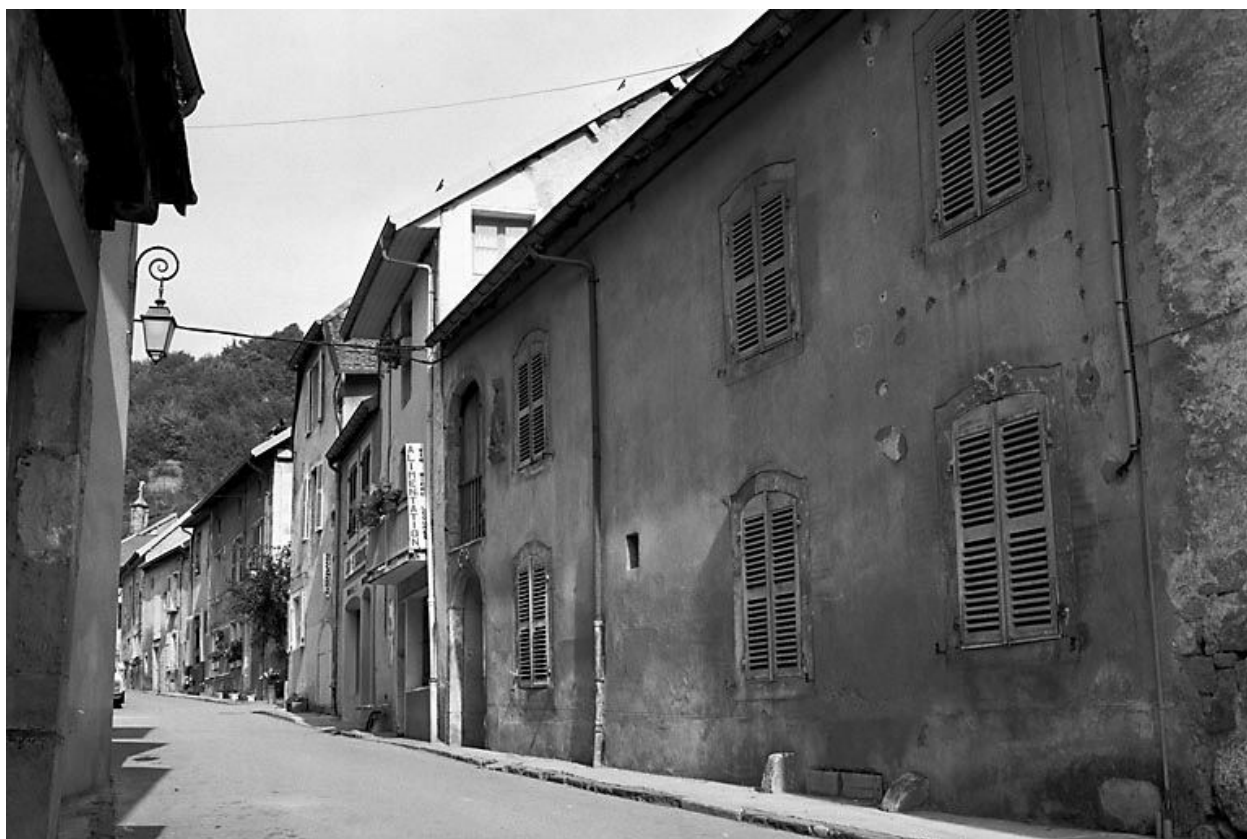
Maison de vigneron située 30 Grande Rue.
