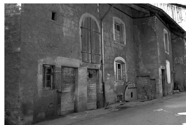
Maison de vigneron située 11 rue Robert Dame. Phot. Yves Sancey IVR43_19802501093X
