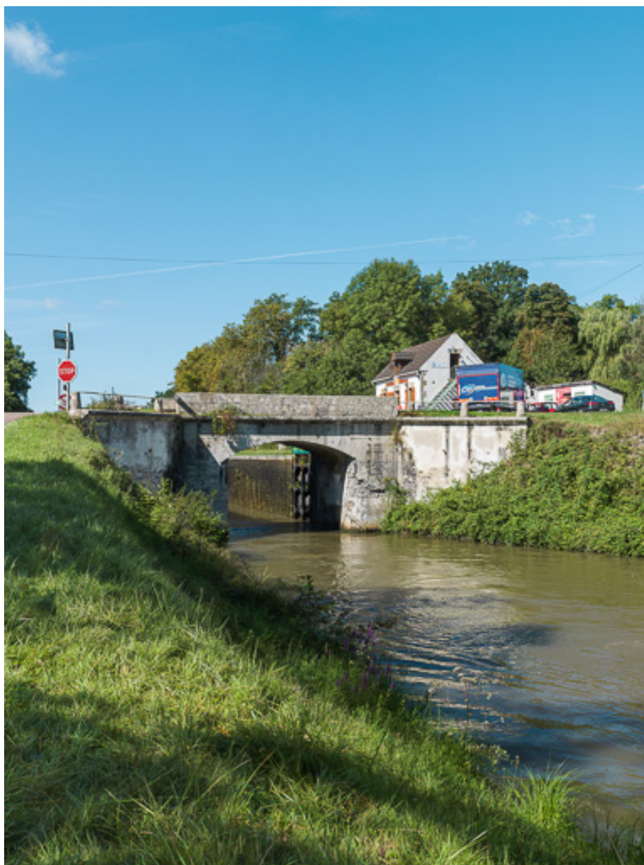
Vue d'ensemble du pont.
