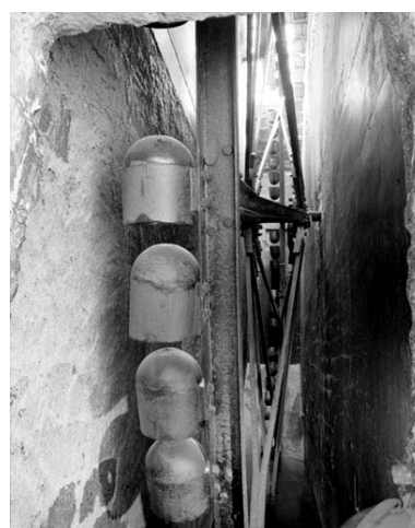
Système de distribution du mélange eau-sable : distributeur et tamis. Phot. Yves Sancey IVR43_19933900318X
