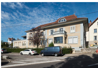
Vue d'ensemble depuis le sud-est. Phot. Jérôme Mongreville IVR43_20172501166NUC4A
