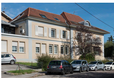
Atelier principal, vu de trois quarts gauche. Phot. Jérôme Mongreville IVR43_20172501167NUC4A
