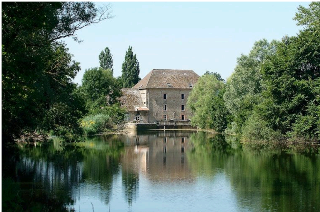
Moulin de Loisy, vu d'amont.
