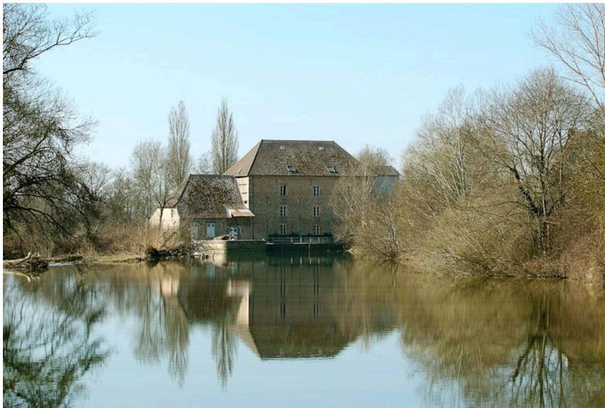
Moulin de Loisy, vu d'amont.
