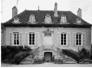
Vue de la façade. Phot. Michel Thierry IVR26_19792101351V
