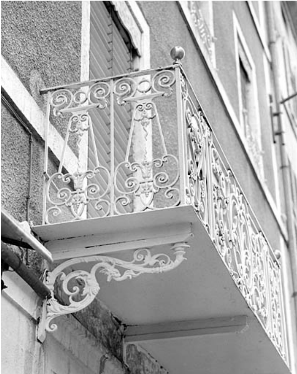
Balcon du premier étage : garde-corps et console.
