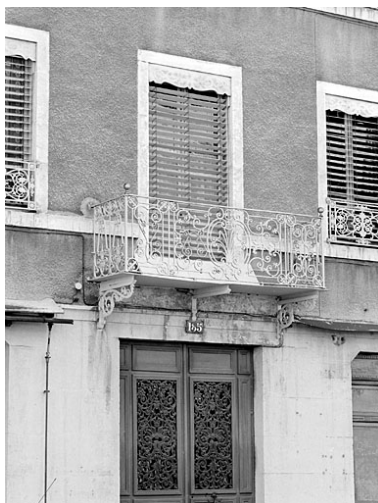
Entrée principale et balcon. Phot. Yves Sancey IVR43_20033900472X
