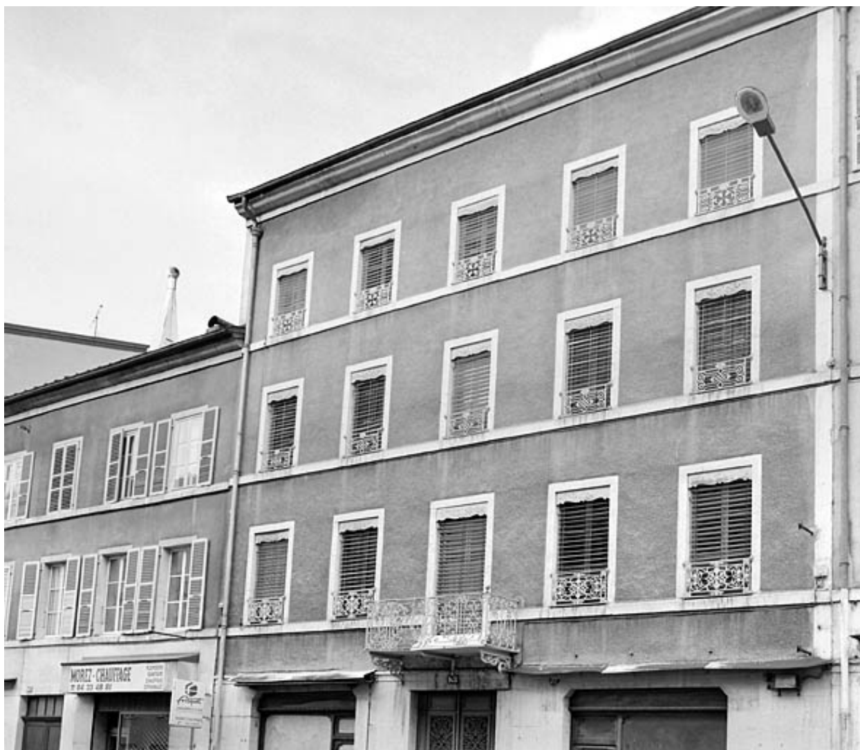
Elévation antérieure : les baies des étages.
