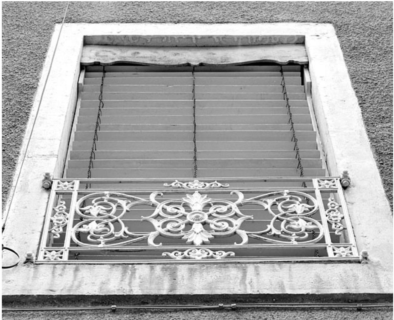
Fenêtre du premier étage et son garde-corps.
