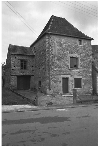
Vue d'ensemble. Phot. Bernard Lardière IVR43_19817000585Z
