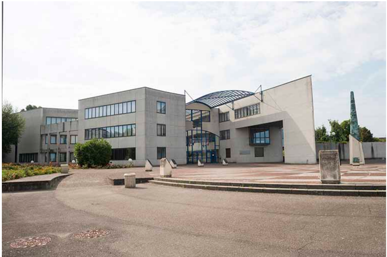
Parvis du lycée.
