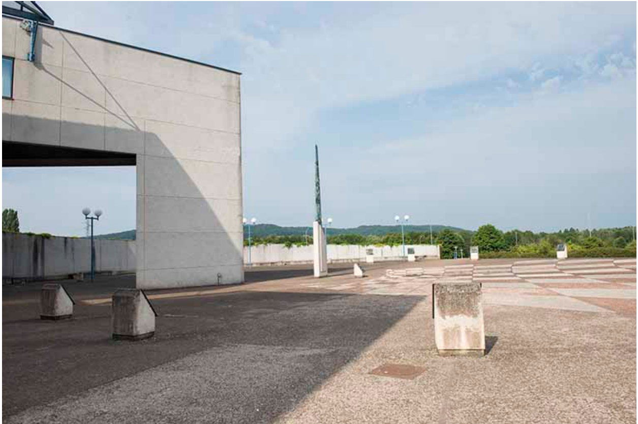
Parvis du lycée.
