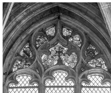
Tympan d'une des baies latérale. Phot. Yves Sancey IVR43_19822500210X
