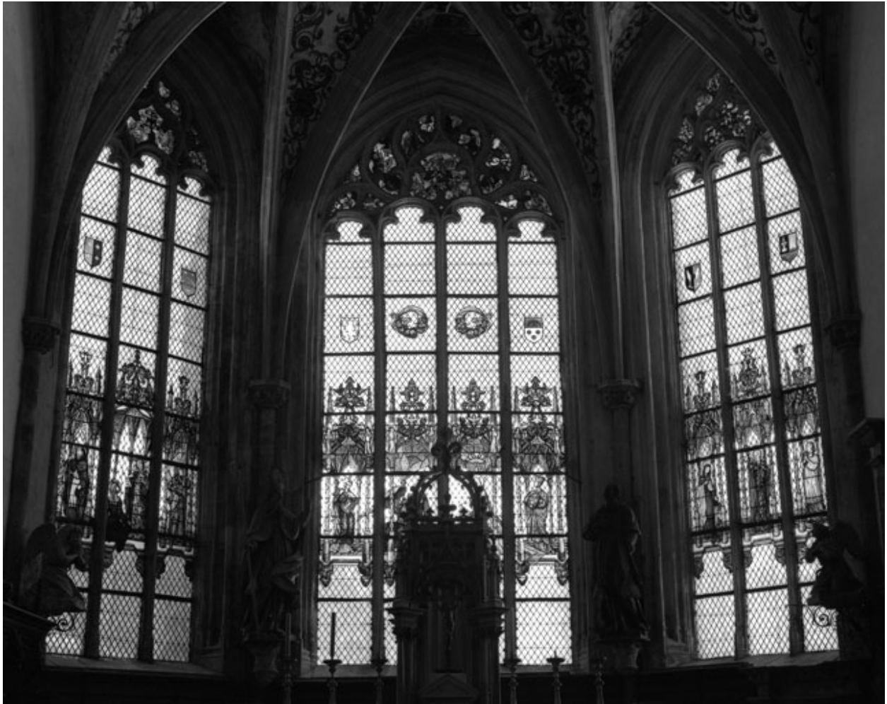
Vue d'ensemble des baies du chœur.
