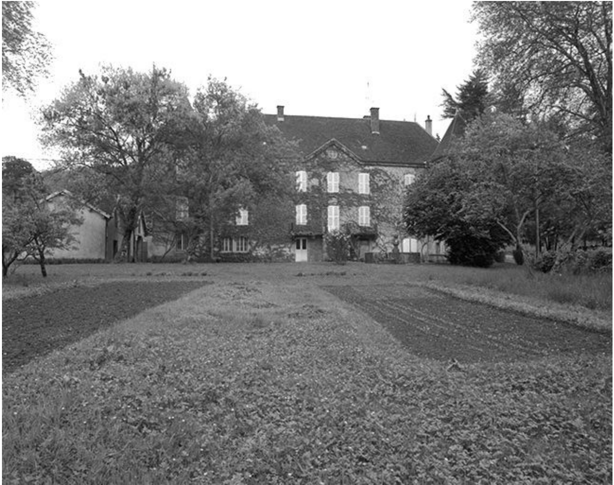
Château située au lieudit La Valbonne et Culée.
