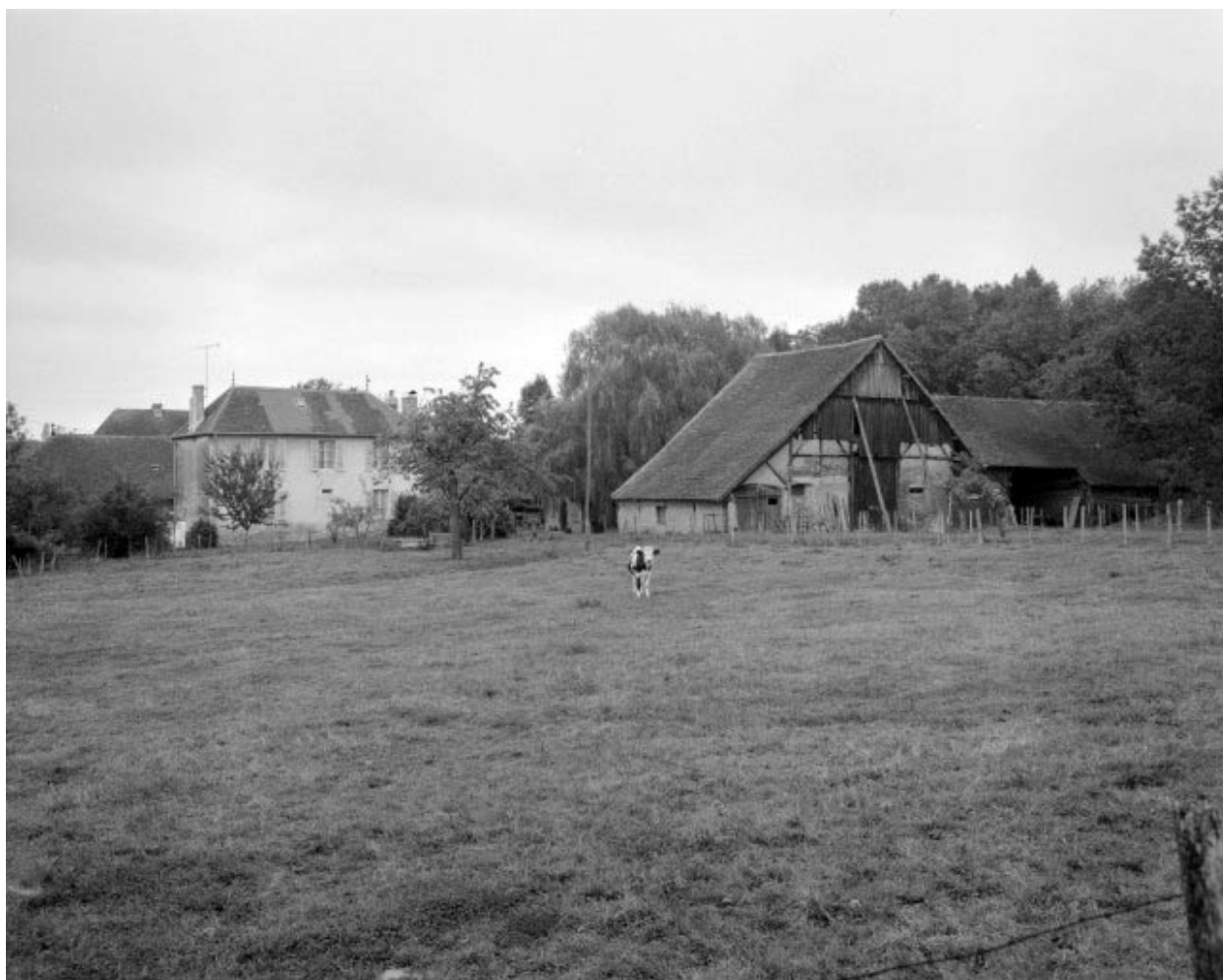
Tuilerie-briqueterie située dans l'impasse de la Tuilerie.
