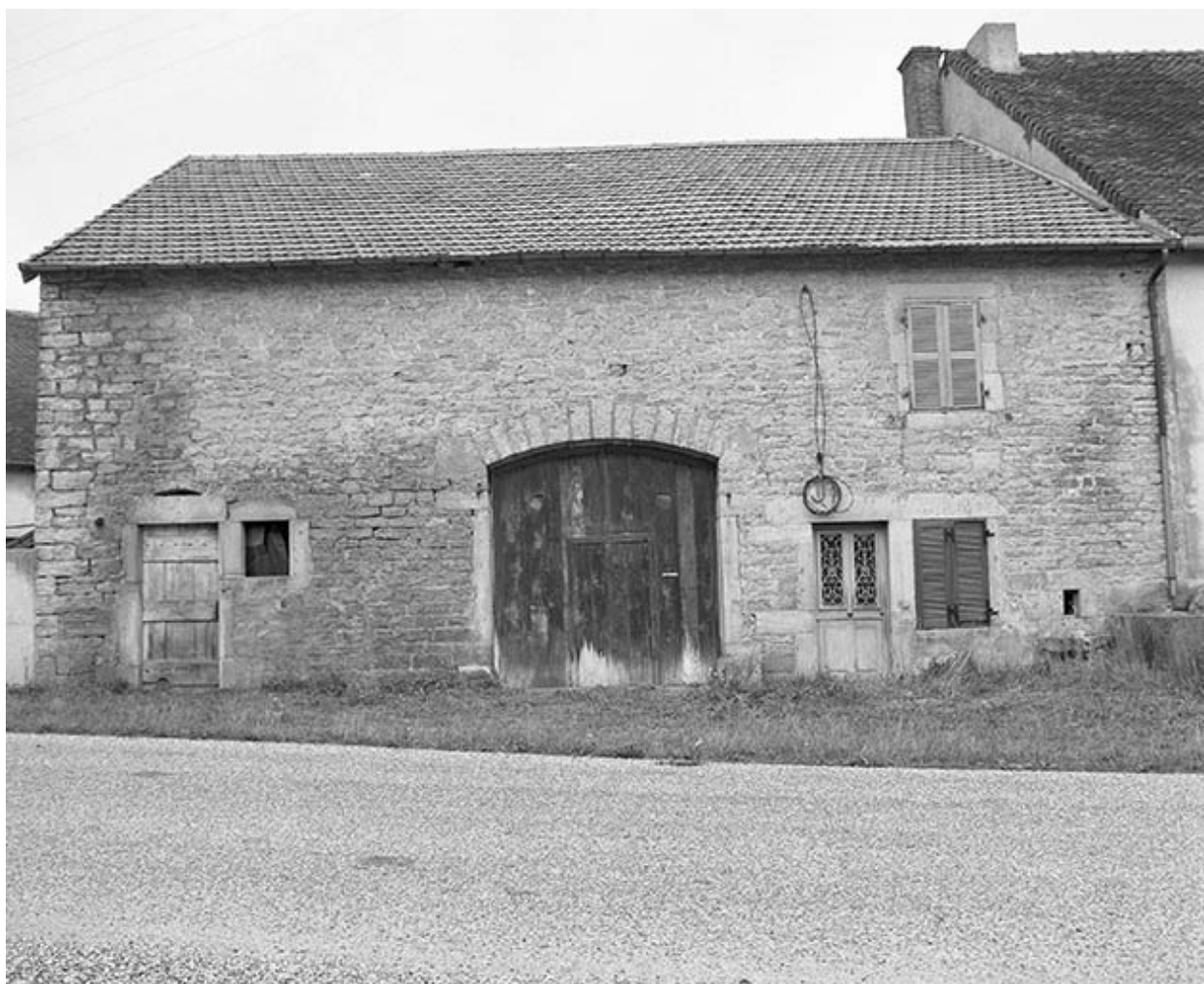
Façade antérieure, de face.
