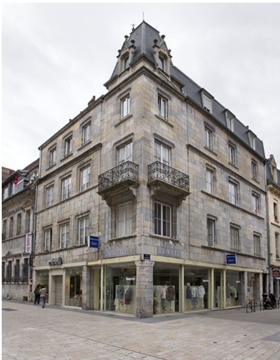
Vue d'ensemble du logis principal.
