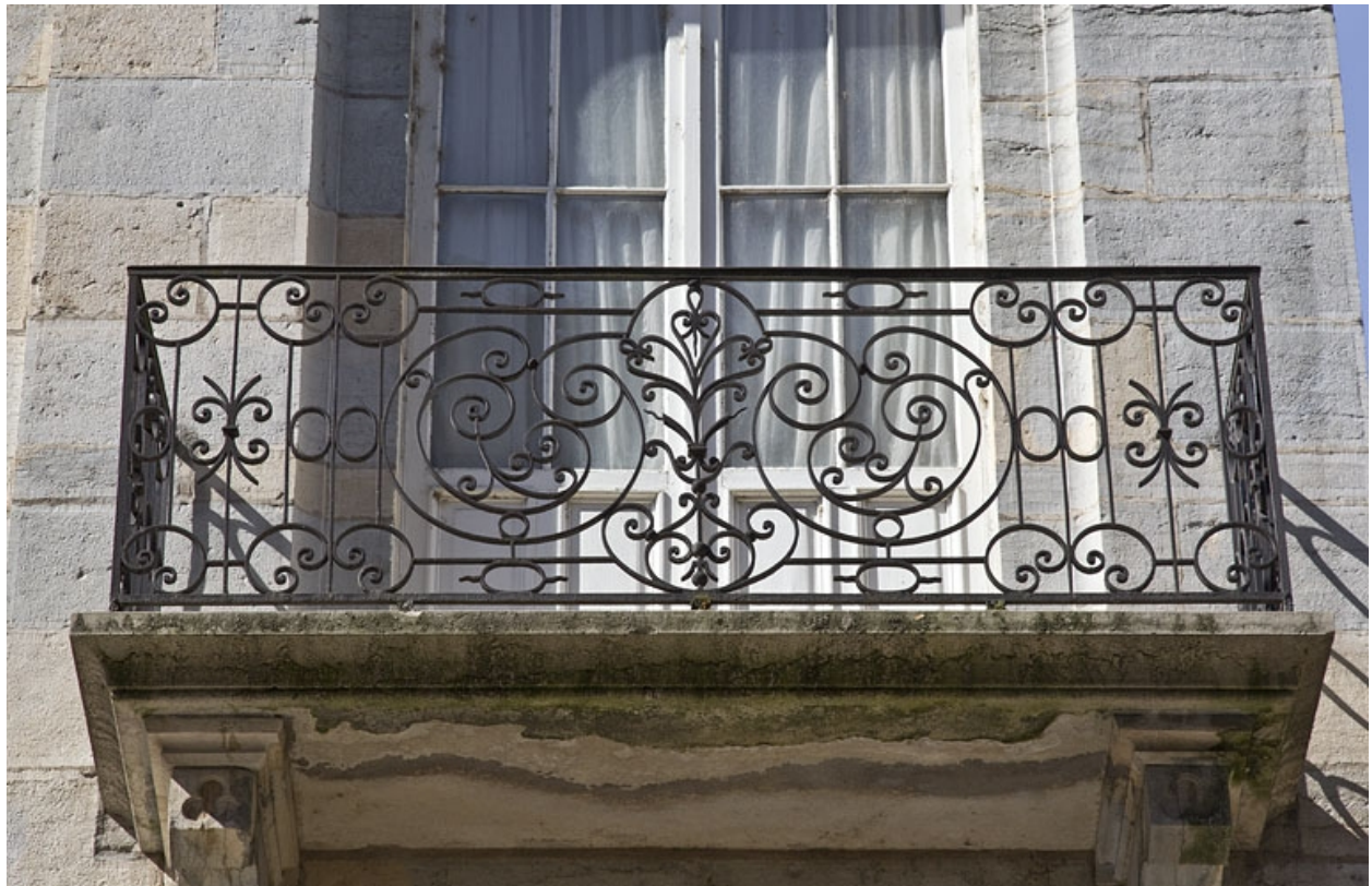
Logis principal : détail d'un balcon en ferronnerie.
