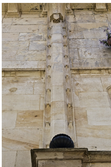
Logis secondaire, façade antérieure : détail d'un pilastre.
