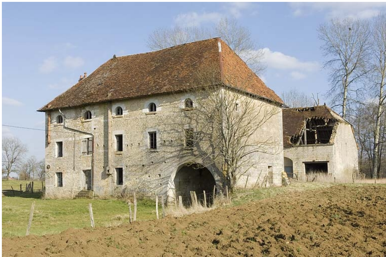
Vue depuis l'ouest.
