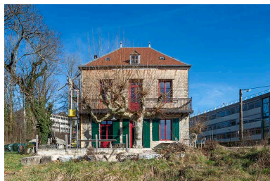
Pignon sud-ouest. Phot. Jérôme Mongreville IVR43_20243900024NUC4A
