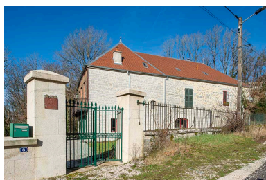
Vue d'ensemble depuis l'entrée. Phot. Jérôme Mongreville IVR43_20243900021NUC4A
