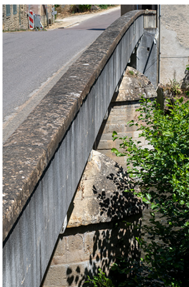
Les piles, le garde-corps et le tablier. Phot. Nicolas Waltefaugle IVR26_20268900287NUC4A
