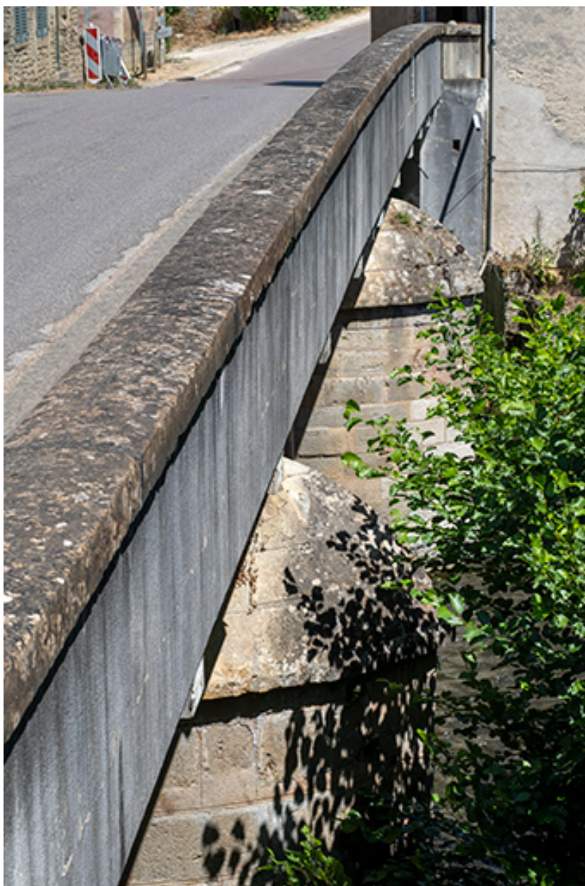
Les piles, le garde-corps et le tablier.
