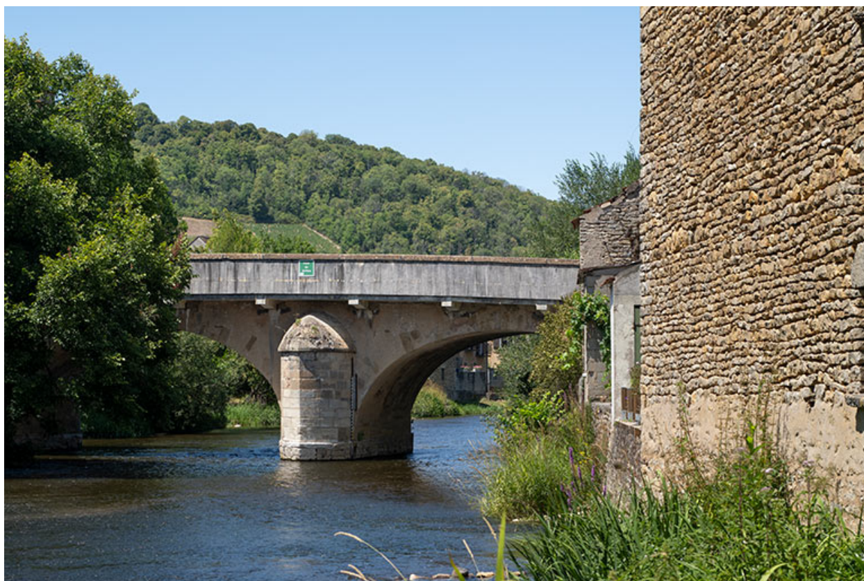
Le pont vu en amont.
