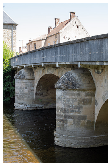
Le pont vu en aval. Phot. Nicolas Waltefaugle IVR26_20268900288NUC4A
