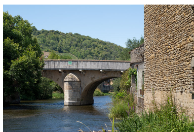
Le pont vu en amont. Phot. Nicolas Waltefaugle IVR26_20268900284NUC4A
