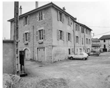
Face postérieure et face droite. Phot. Jérôme Mongreville IVR43_19853900114X
