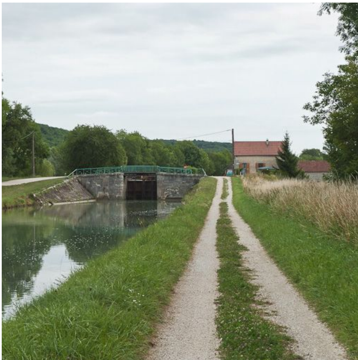
Vue du pont depuis l'aval.
