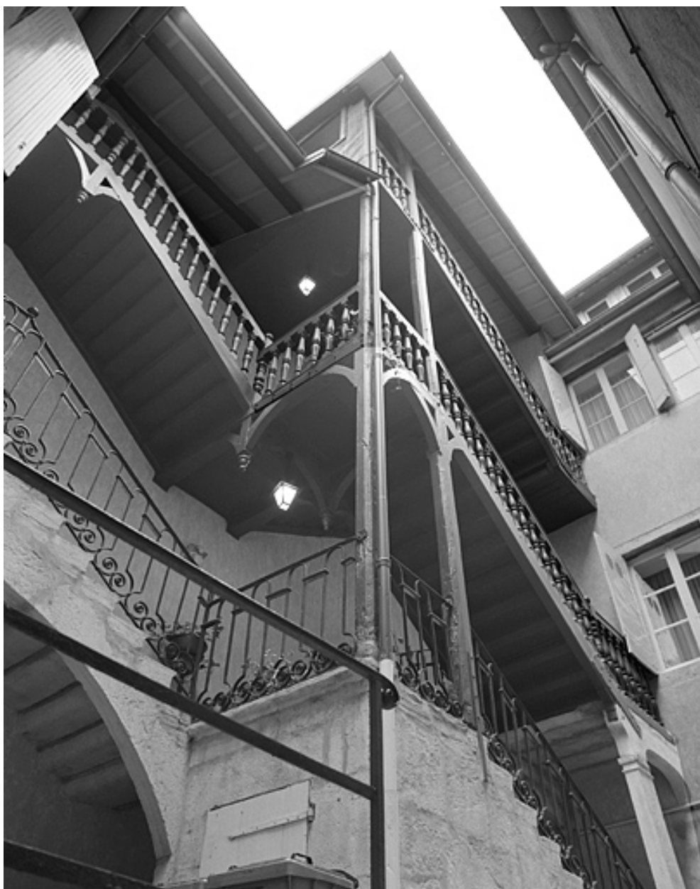
Escalier dans la cour.
