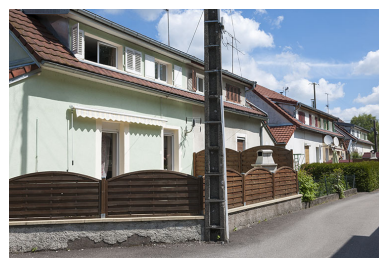
Groupe de trois maisons jumelées. Phot. Jérôme Mongreville IVR43_20132500425NUC4A
