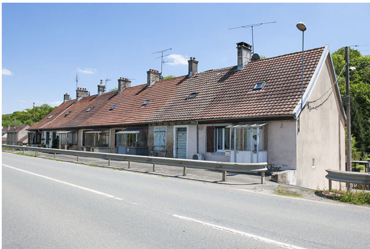
Habitation de type caserne. Vue depuis l'ouest.
