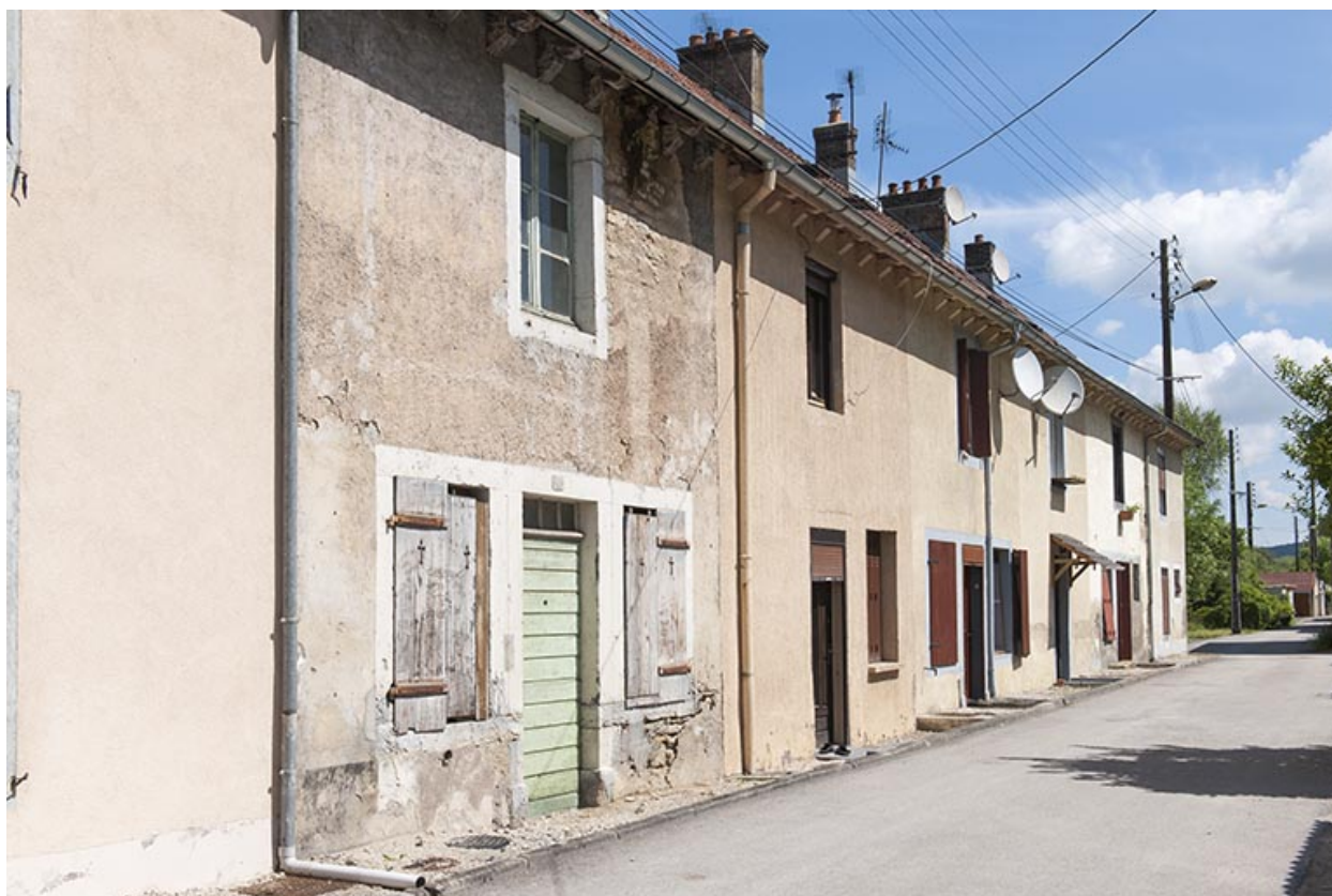
Façade sud d'un logement de type caserne.
