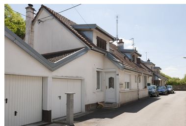
Façade nord de maisons jumelées. Phot. Jérôme Mongreville
