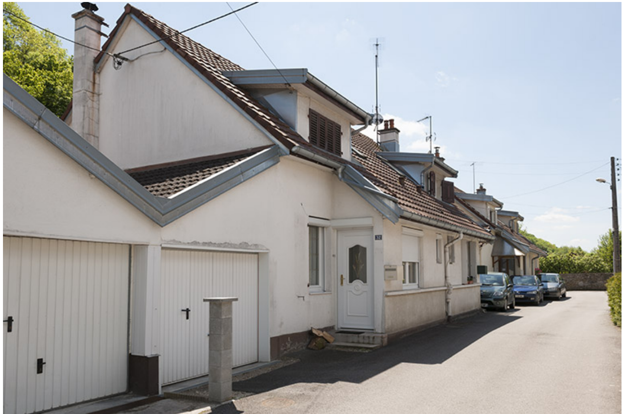
Façade nord de maisons jumelées.
