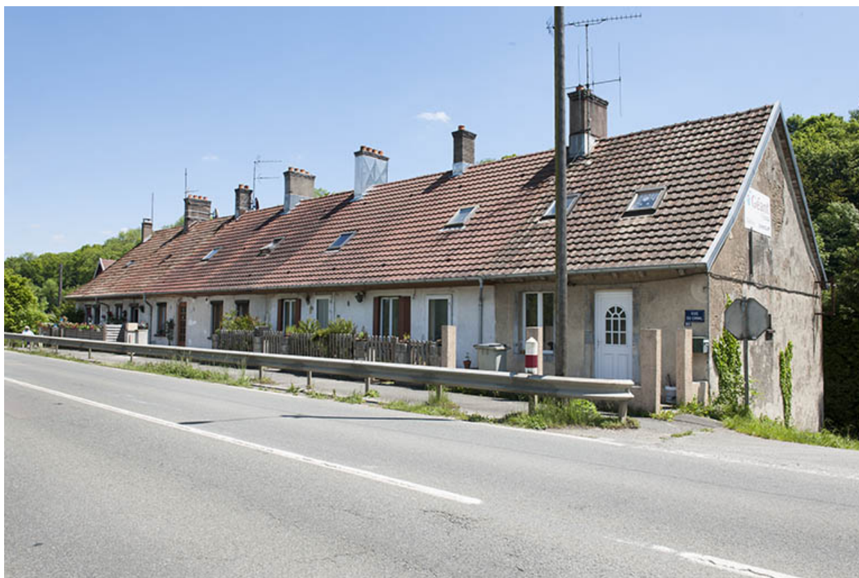
Habitation de type caserne (commune de Colombier-Fontaine).
