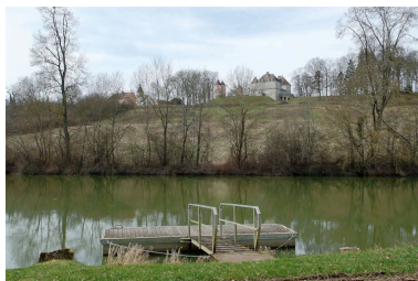
Le château pris de la rive gauche de la Seille. Au premier plan, un appontement moderne. Phot. Jean-Luc Duthu IVR26_20107100429NUC2A
