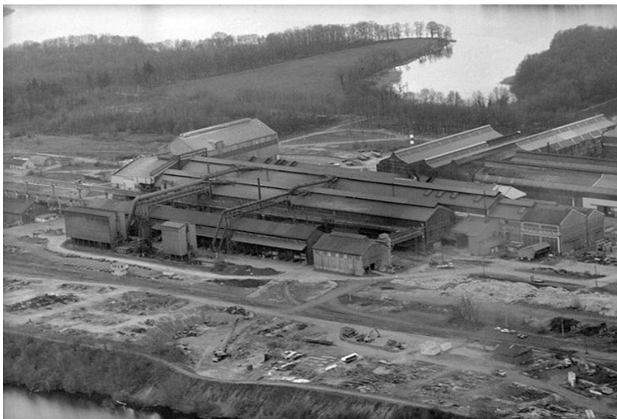
Vue aérienne de l'aciérie depuis le nord-est.
