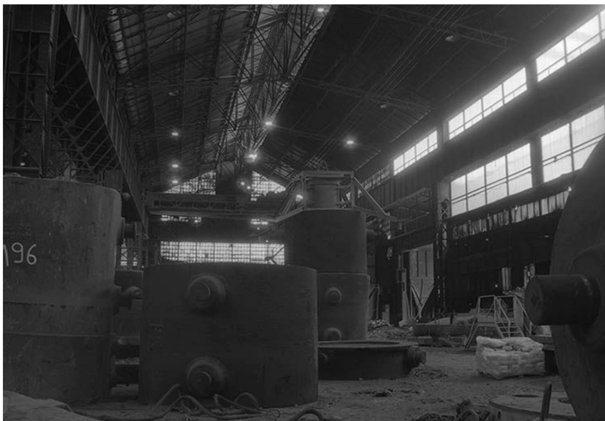
Extrémité nord de la halle des fours.
